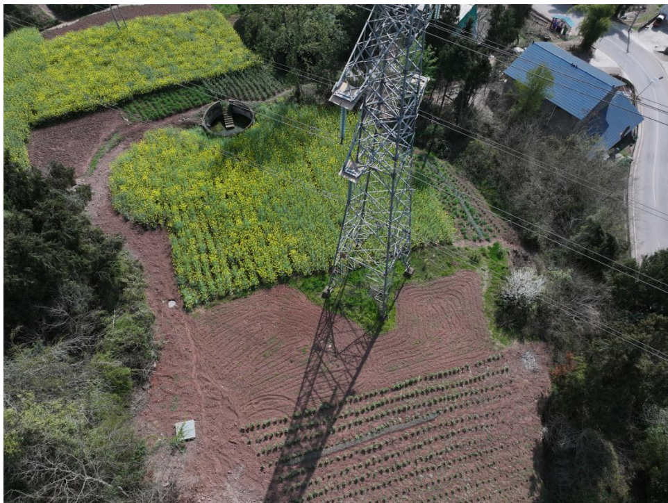
图3-4 塔基区无人机航拍
