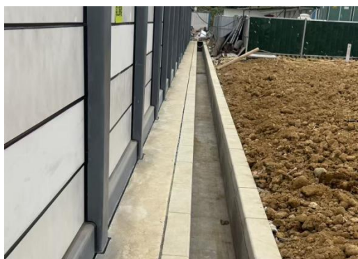
变电站主体区砖砌石排水（2026年2月）
