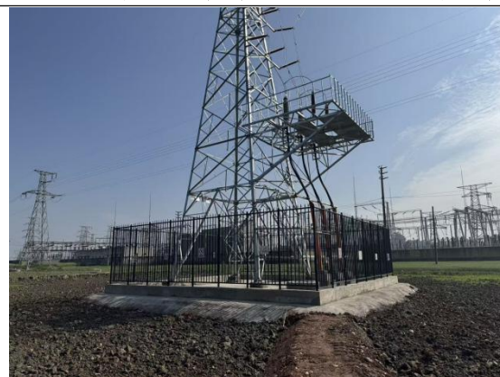
徐家渡M1#号塔基土地整治（2026年2月）
