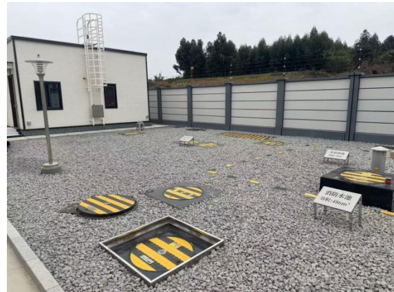
变电站主体区透水碎石地坪（2026年2月）
