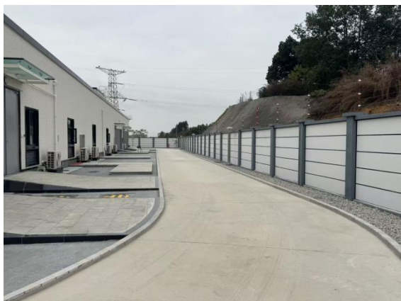
变电站主体区透水混凝土地坪（2026年2月）
