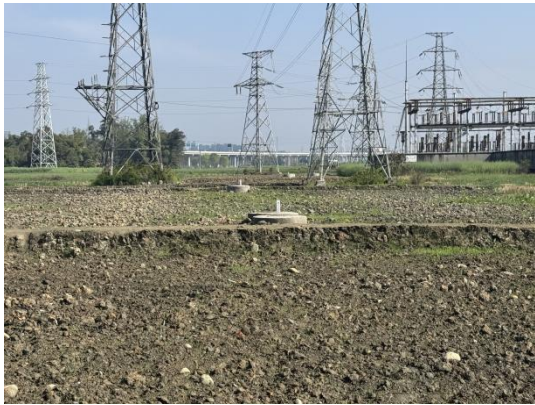
电缆铺设区土地整治 (2026年2月)
