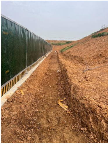
变电站主体工程区土质临时排水（2025年5月）
