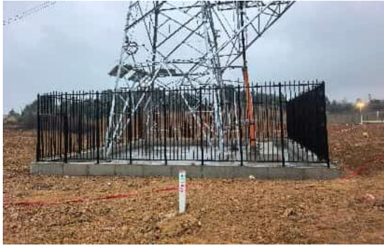
邓双N2#号塔基土地整治 (2026年2月)
