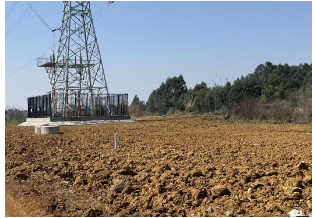
电缆铺设区土地整治 (2026年2月)
