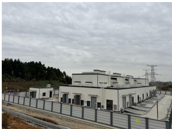
变电站主体区（2026年2月）
