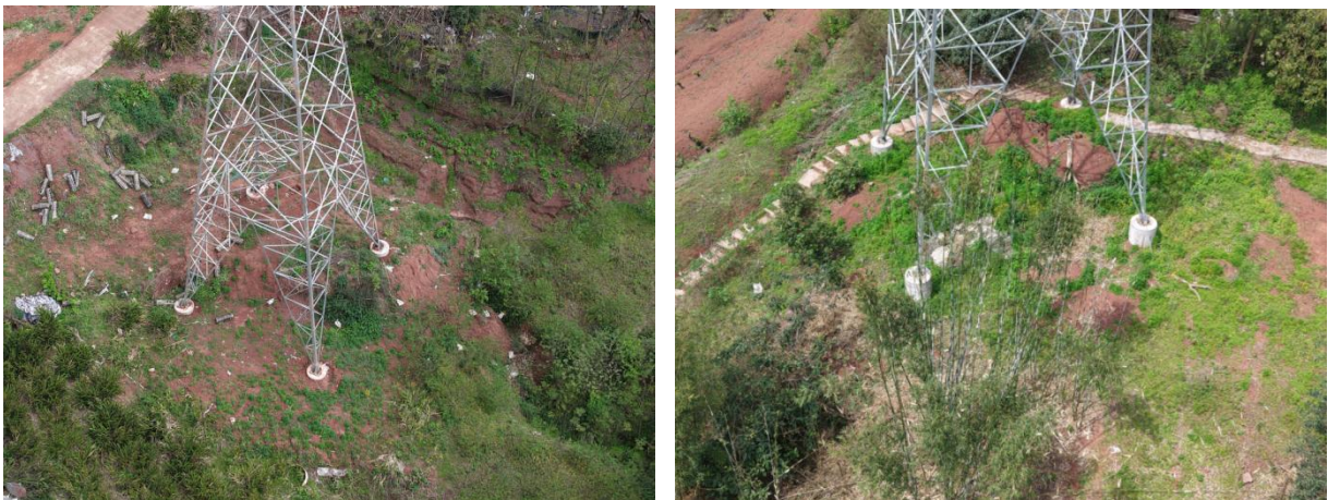
塔基及其施工临时占地表土回覆、土地整治、植被恢复
