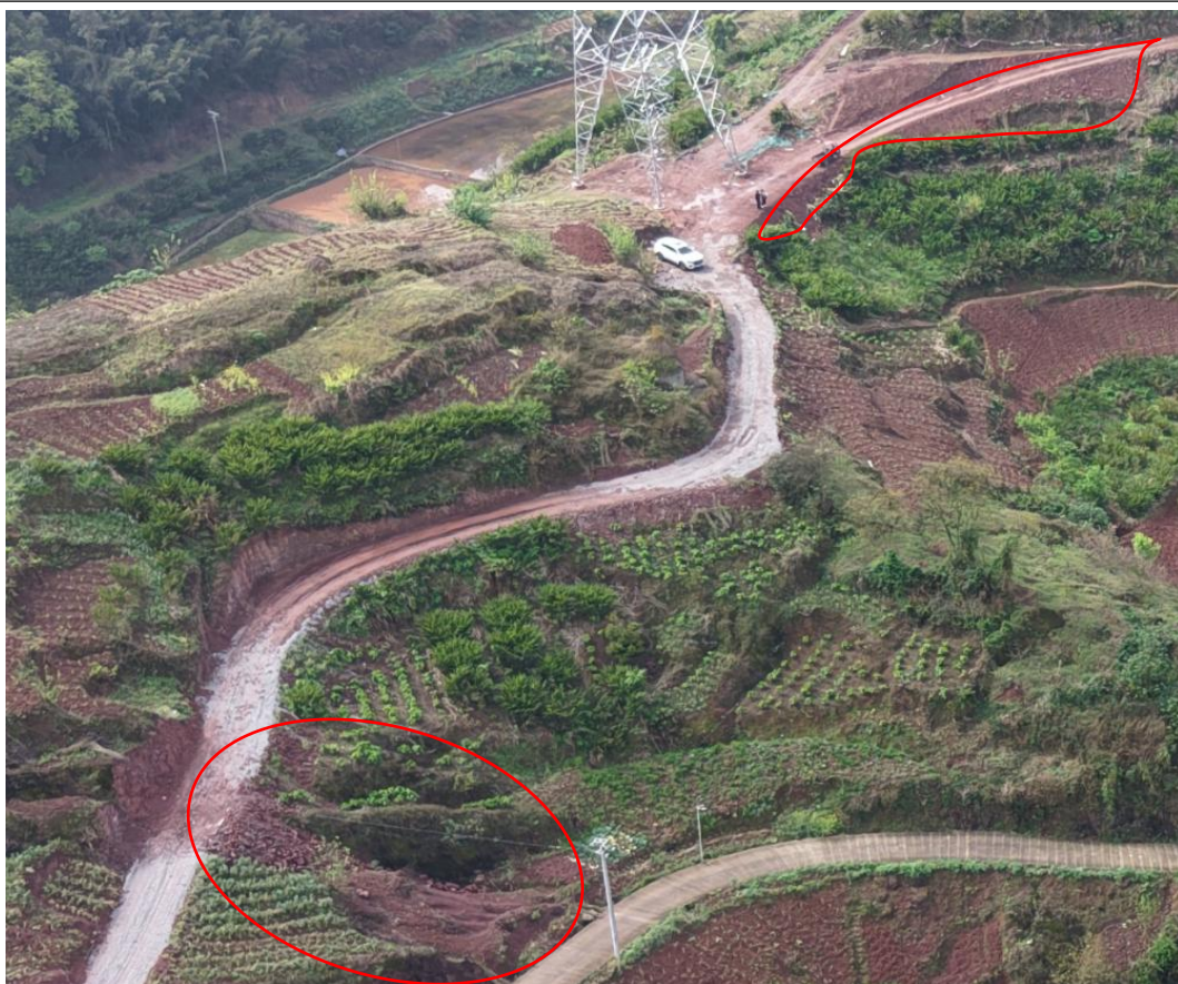
AN16 塔基及其施工临时占地未采取植被恢复，汽运道路坡面部分区域存在溜渣
