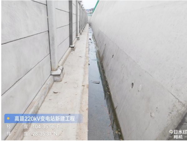
站外排水沟（北侧）
