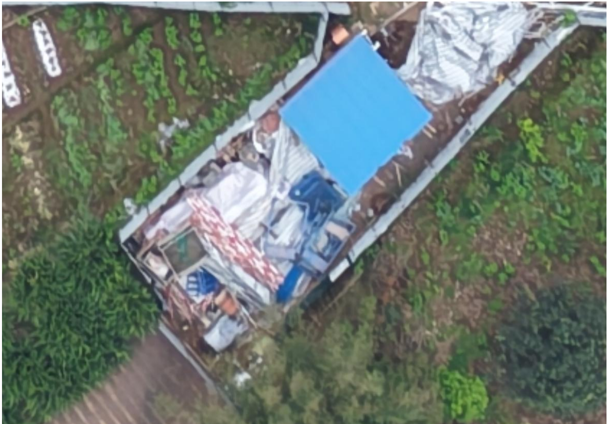
钢筋及木工加工场临时苫盖
