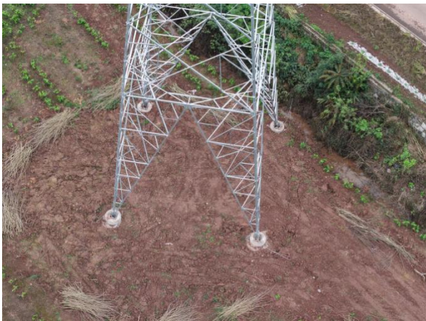
塔基占地表土回覆、土地整治
