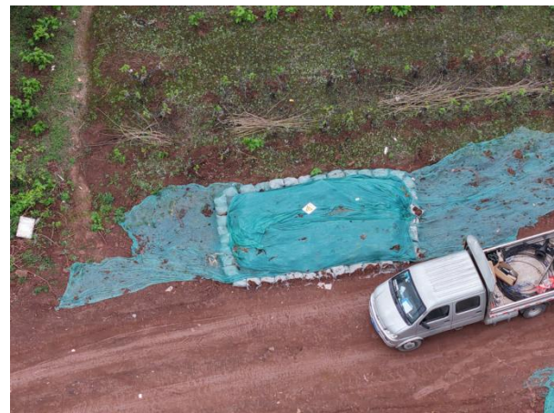
汽运道路表土剥离、土袋拦挡、临时苫盖
