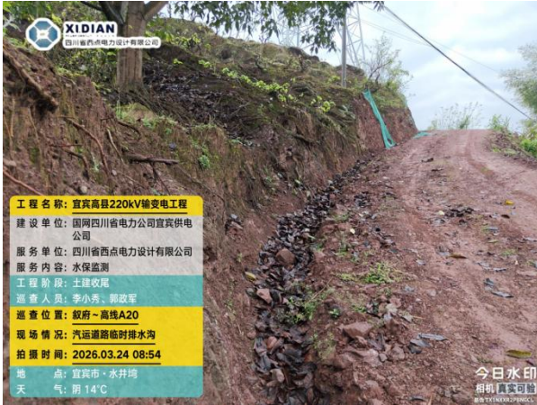
汽运道路临时排水沟
