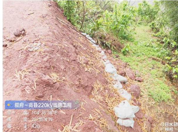
汽运道路土袋拦挡
