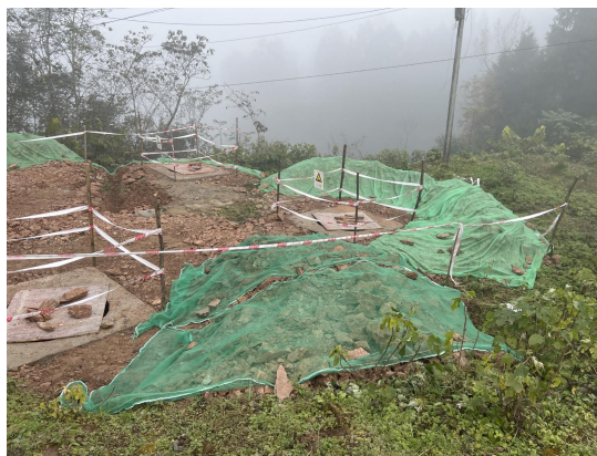
图8-2 塔基工程区采用密目网苫盖
