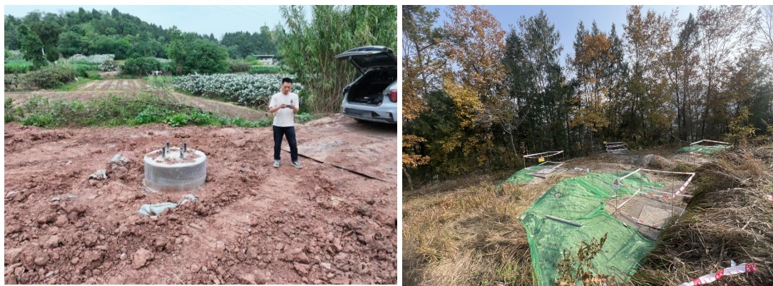
图3-6、图3-7 施工人员对现场采用无人机航拍及实际调查监测
