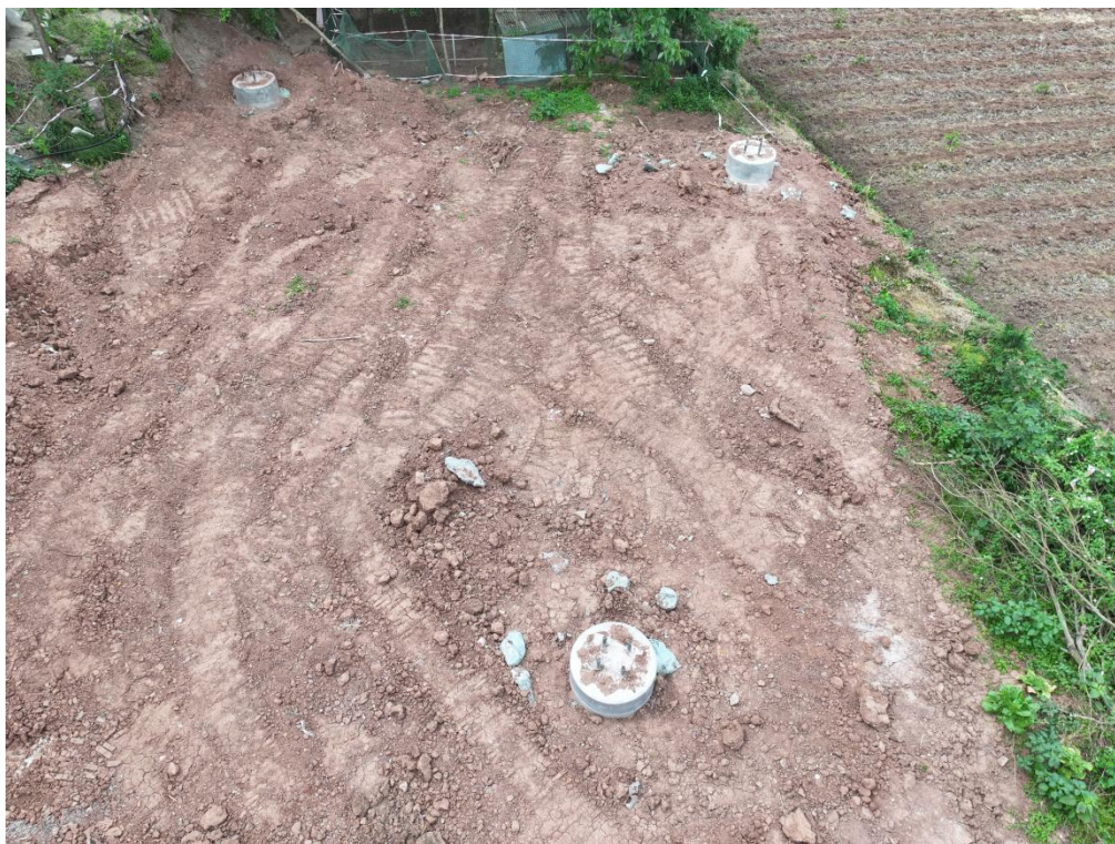
图3-2 塔基区无人机航拍
