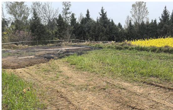
图8-1 塔基工程区采用密目网苫盖
