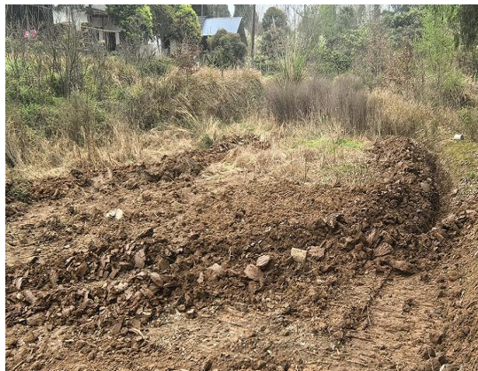
图8-4 塔基区开挖临时排水沟
