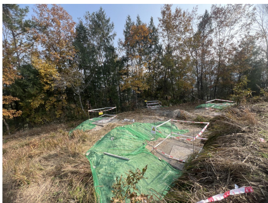
图8-3 塔基工程区采用密目网苫盖
