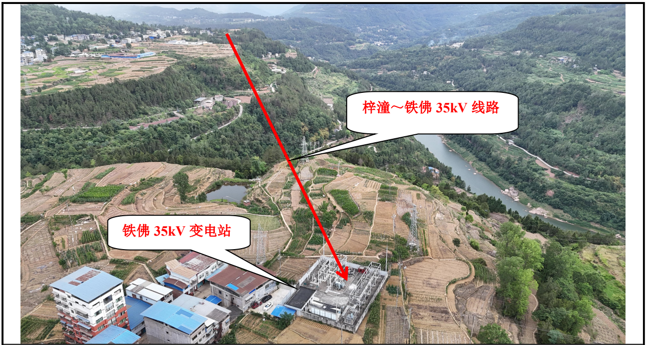
铁佛 35kV 变电站附线路沿线地形地貌
