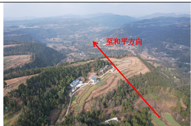
马鞍~和平 35kV 线路沿线地形地貌 (官田塘)
