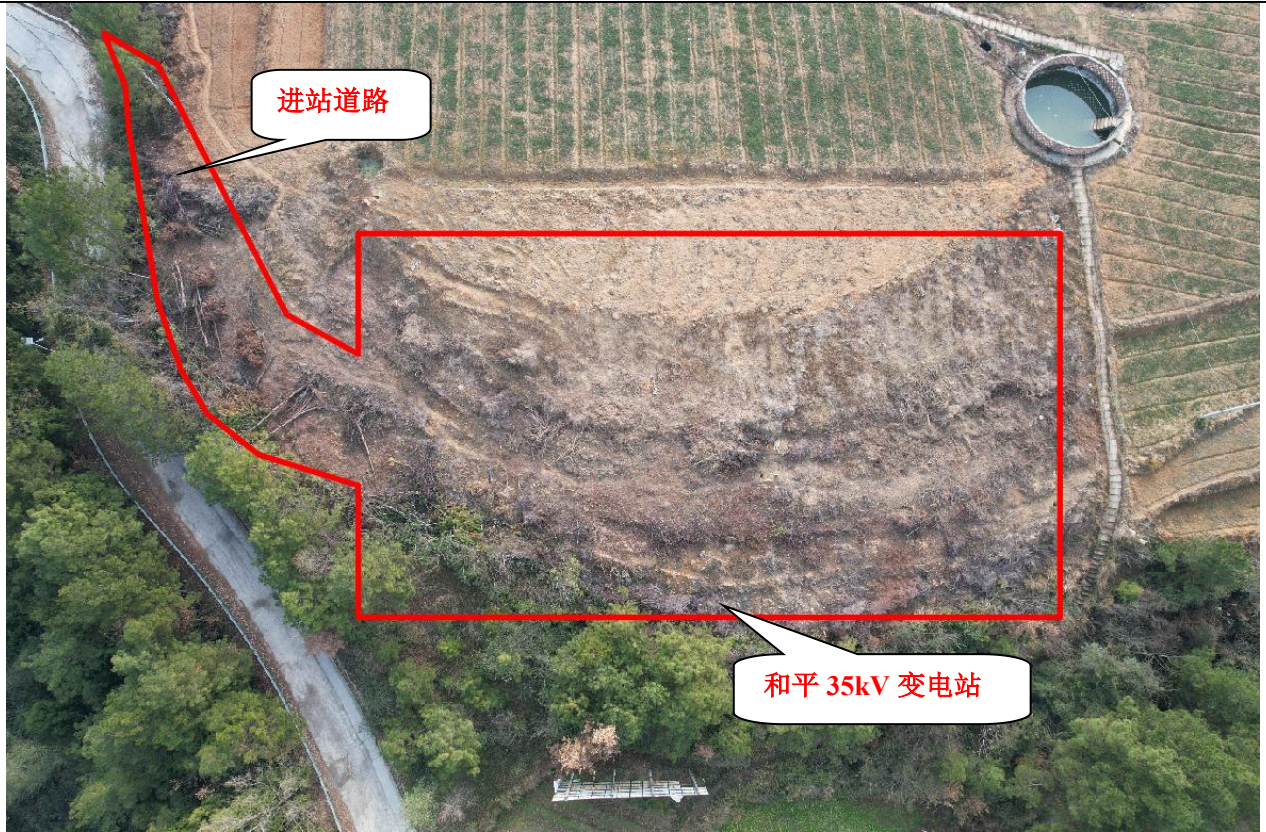
和平 35kV 变电站站址现状
