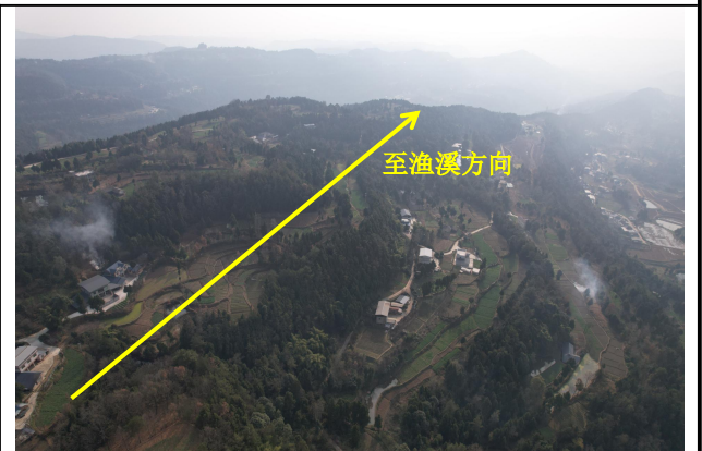
和平~渔溪 35kV 线路沿线地形地貌 (柏林坡)
