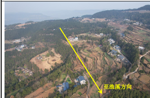
和平~渔溪 35kV 线路沿线地形地貌 (文通村)
