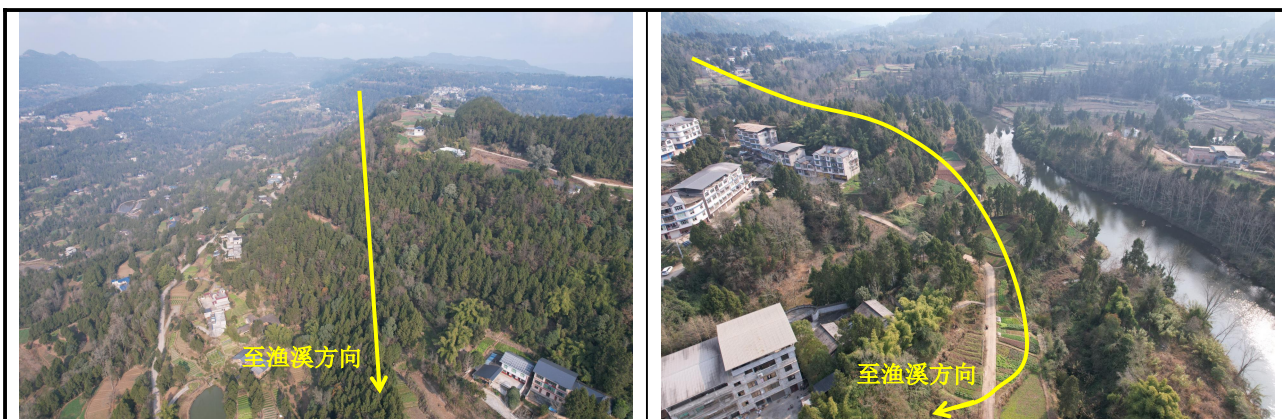
和平~渔溪 35kV 线路沿线地形地貌（龚家院）
