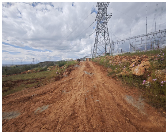
施工道路区域现状
