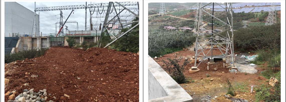
施工道路区域土地整治
