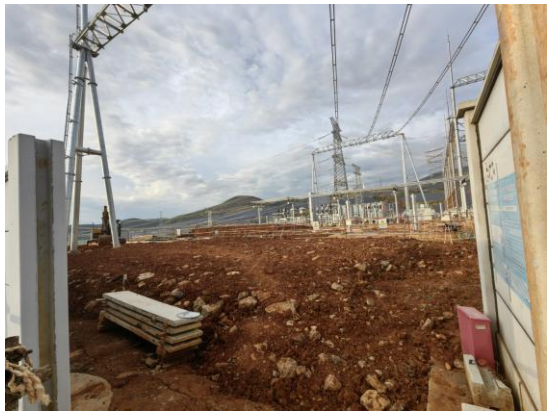
站外主变扩建区域现状
