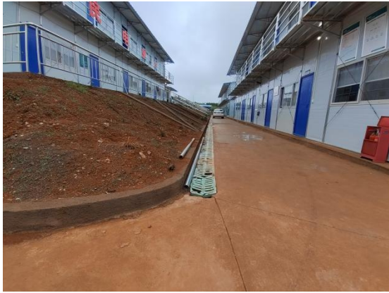
图 4.1-13 施工场地临时排水沟
