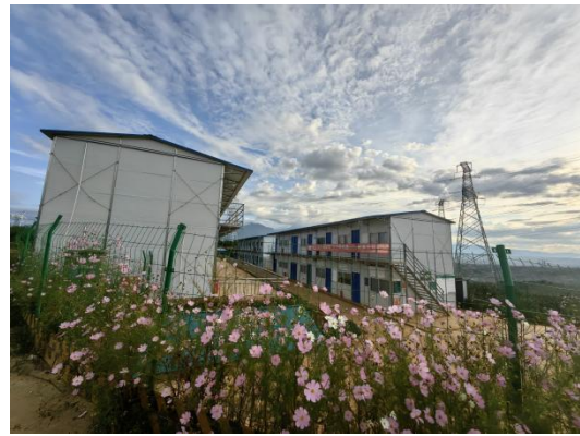
图 4.1-16 施工场地临时绿化
