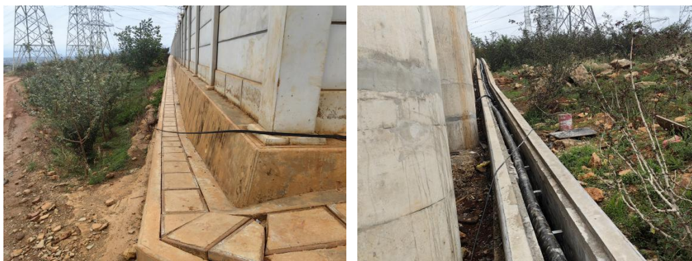
图 1.1-4 路面式电缆沟
