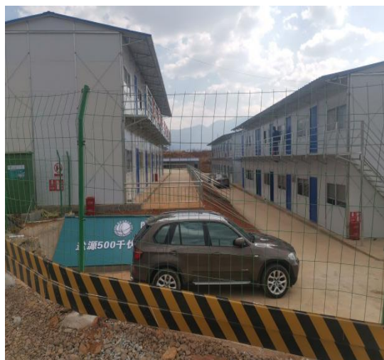
施工营地占用范围围挡
