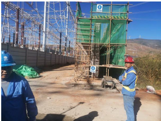
东侧扩建场地现状
