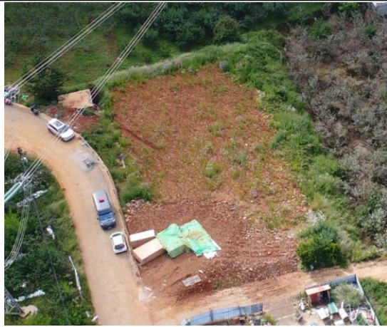
施工场地区域土地整治
