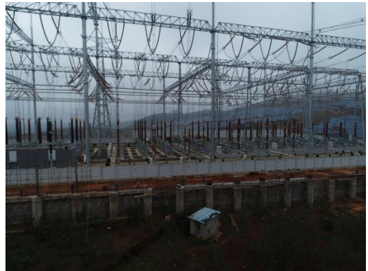
东侧扩建区域现状
