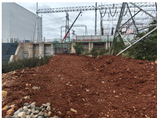
图 1.3-3 施工道路区监测点
