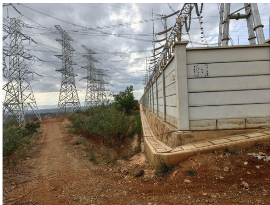
施工营地现状
