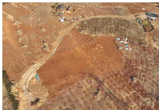
图 4.1-3 施工场地土地整治
