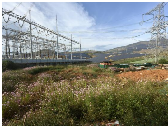
施工场地部分区域植被恢复
