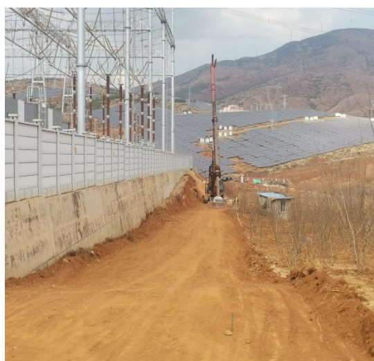
施工道路区域表土的剥离堆存
