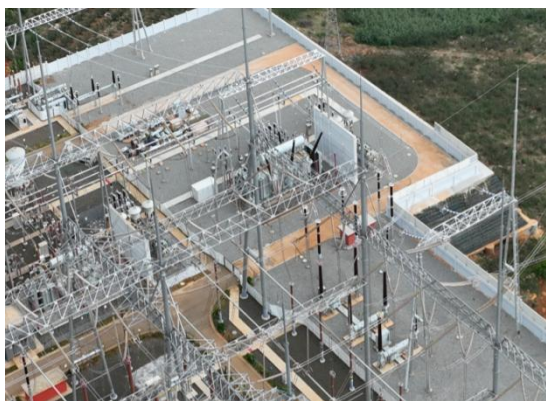
图 4.1-1 变电站扩建区碎石铺设、排水管网
