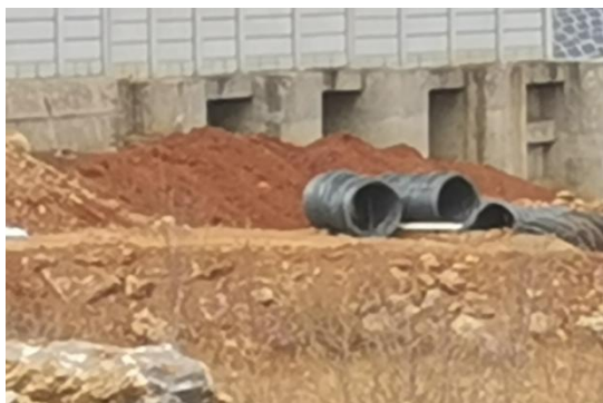
图 4.1-7 变电站扩建区域表土剥离
