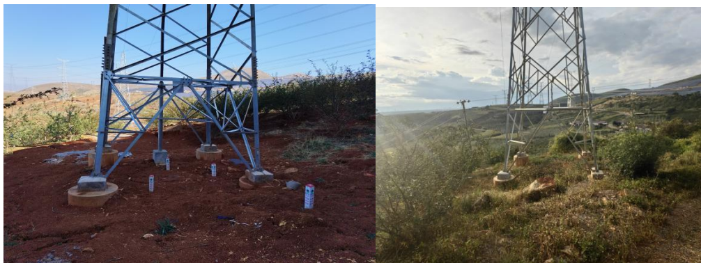
图 1.1-3 新建 35 千伏塔基施工场地布设情况
