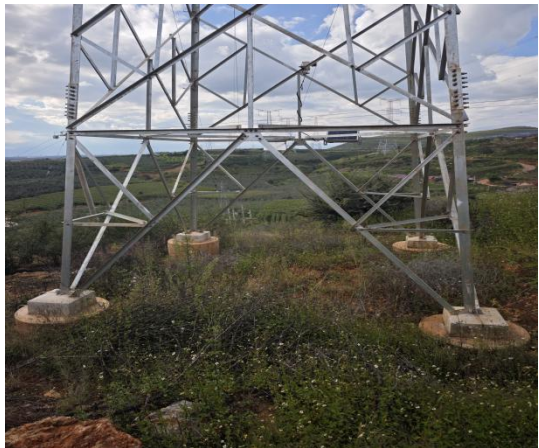
新建塔基区域现状
