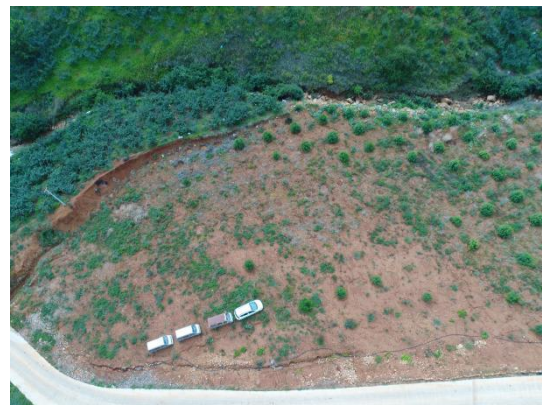
施工道路区域现状
