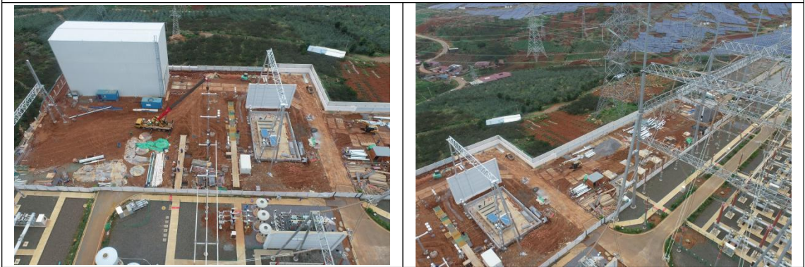
站外主变扩建区域现状
