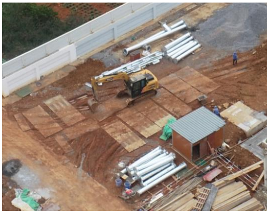
图 4.1-15 扩建场地钢板铺垫
