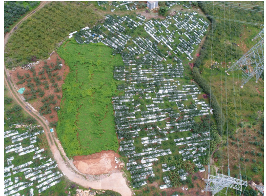
施工场地区域土地整治、迹地恢复
