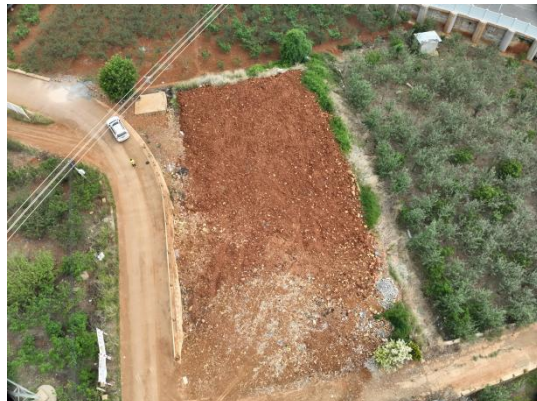
图 4.1-2 施工场地土地整治
