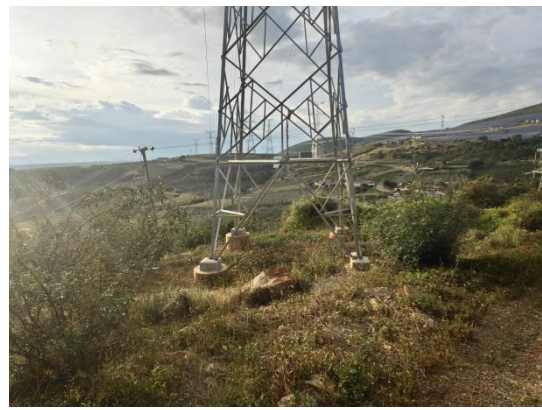
图 4.1-10 新建塔基区域植被恢复
