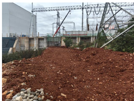
图 4.1-5 施工道路土地整治
