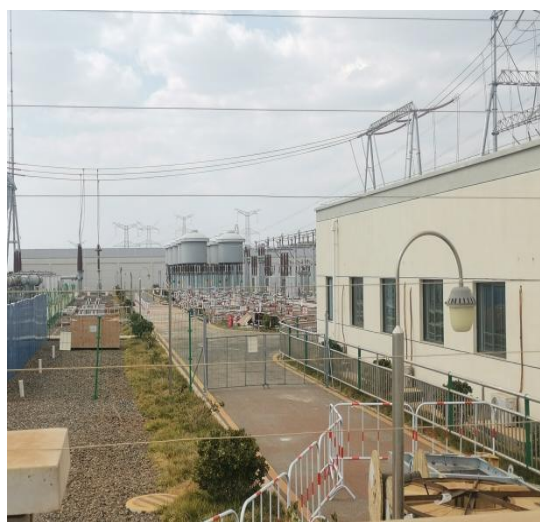
施工区域围挡
