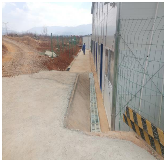
施工营地周边临时排水沟
