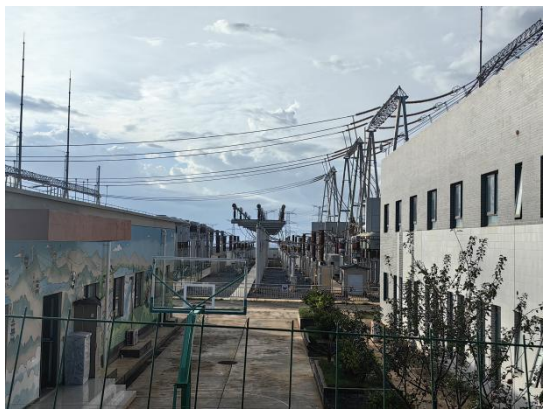
原站内主变扩建区域现状
