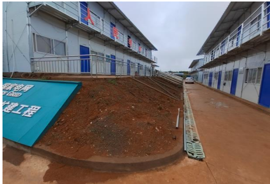
施工营地周边临时排水沟
