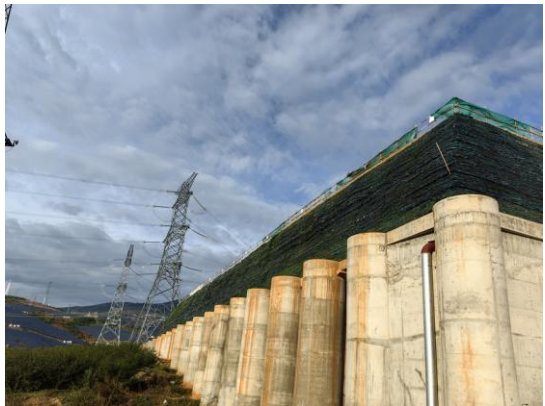
土工格栅草袋护坡
