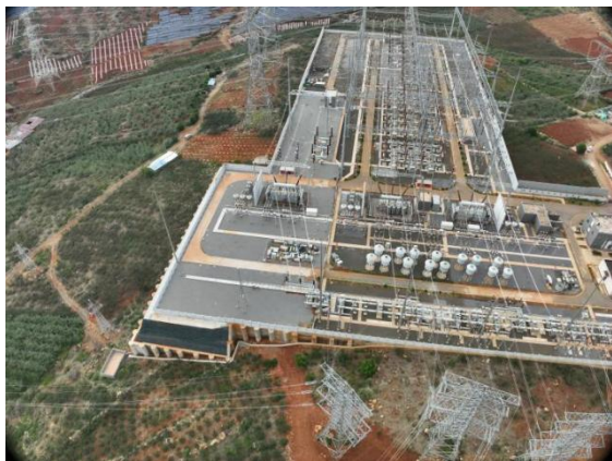
图 1.3-1 变电站扩建工程区监测点
