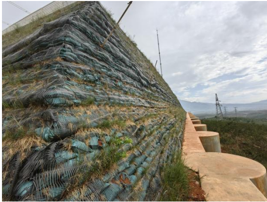
图 4.1-9 土工格栅草袋护坡
