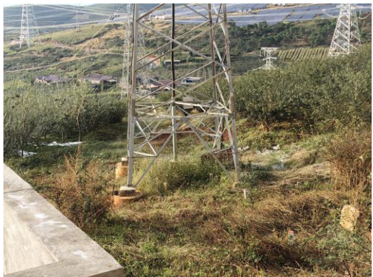
新建塔基区域现状
