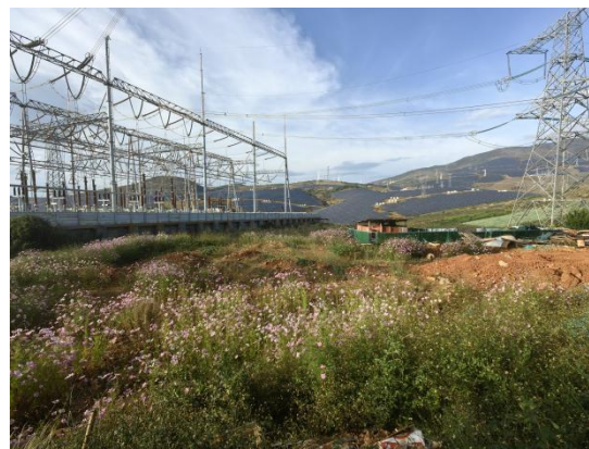
图 4.1-12 施工场地区植被恢复
