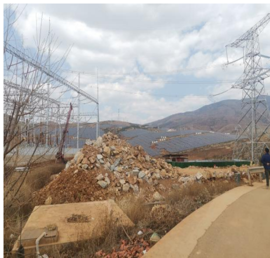
主变基础土石方临时堆存
