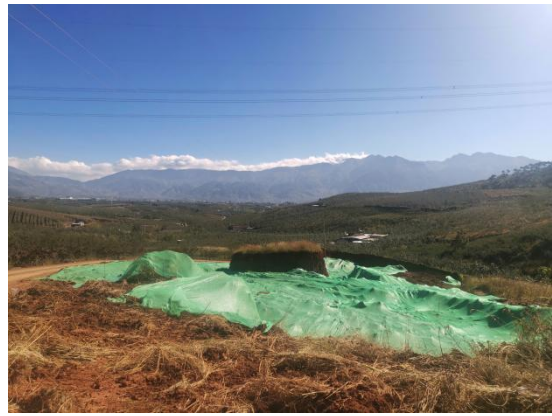
图 4.1-14 取土场临时苫盖
