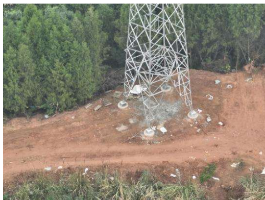
石门 N45 塔基施工场地平整
