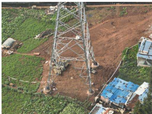
青龙坡 N40 塔基施工场地平整
