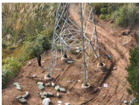
石门 N14 塔基施工场地平整
