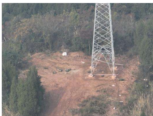
图 4.2-2 青龙坡-太吉 N26 组塔完毕，施工场地未恢
