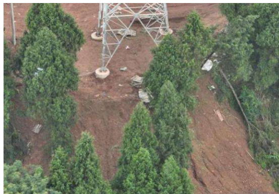
图 4.2-3 石门-太吉 N57 号塔下边坡土方顺坡溜渣
