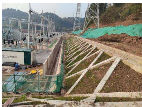
变电站北侧截水沟及边坡
