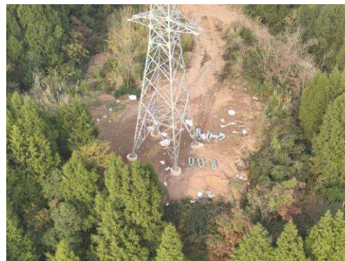
石门 N3 塔基施工场地平整
