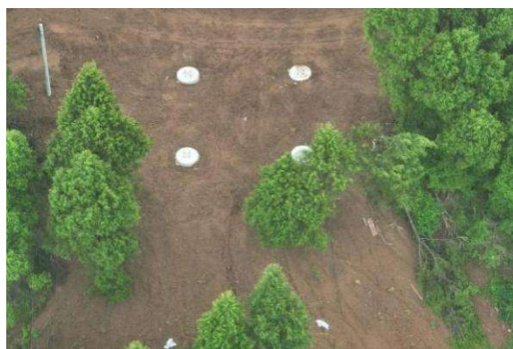
图 4.1-3 石门-太吉 N57 号塔下边坡土方顺坡溜渣
