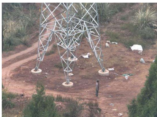
石门 N37 塔基施工场地平整
