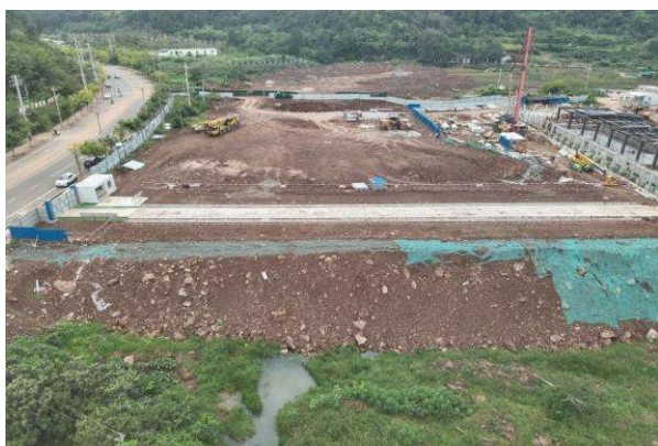
图4.1-1 进站道路边坡临时遮盖风化损毁较为严重
