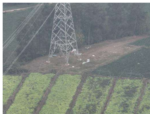
石门 N55 塔基施工场地平整
