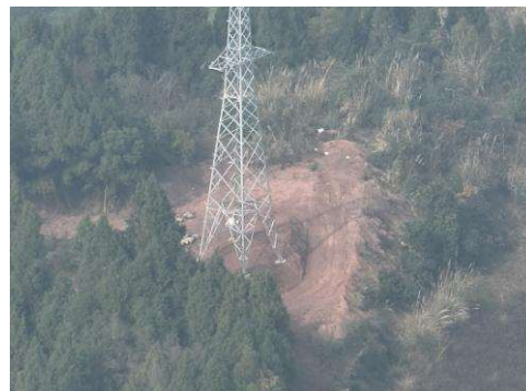
石门 N23 塔基施工场地平整
