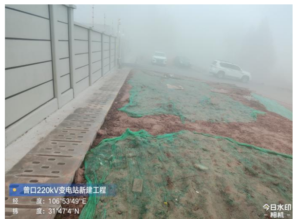
变电站入口施工临时场地土地整治、临时遮盖
