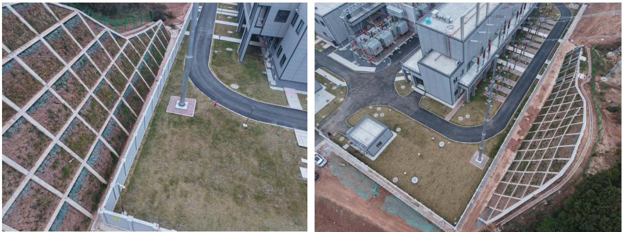
站内草皮绿化、铺透水砖，站外框格梁植被护坡，站外排水沟、沉沙池
