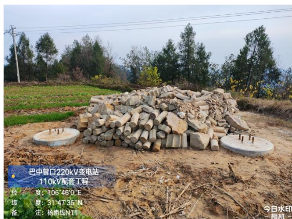
杨南改接线路 N11 塔开挖出的块石未及时清理
