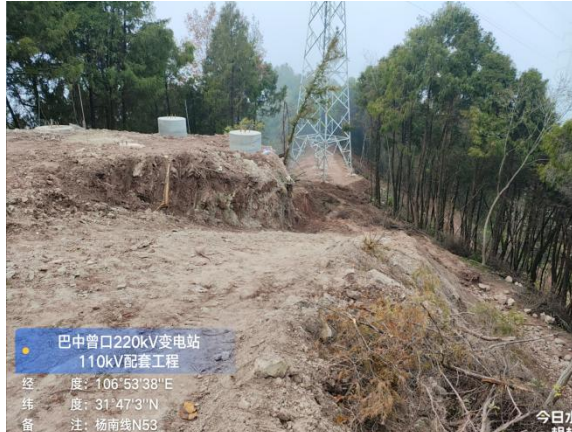
杨南改接线路 N53 塔新修汽运道路未采取临时排水、沉沙、拦挡、苫盖措施
