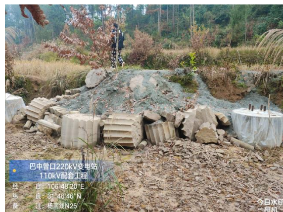
杨南改接线路 N25 塔临时堆土、堆料散乱，砂石料未采取铺垫措施
