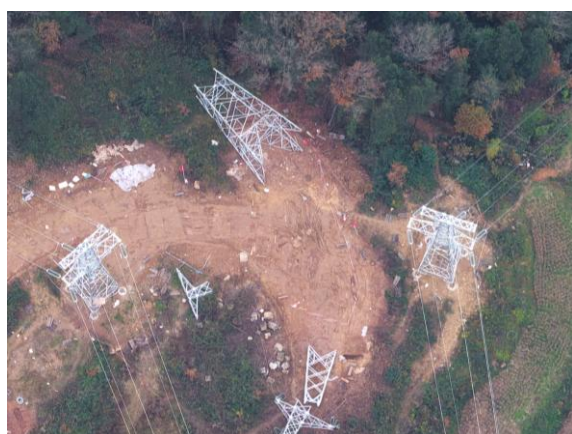
文龙一线 \pi 接线路 N1、N2 塔基及塔基施工场地、铁塔拆除临时占地、牵张场未及时采取土地整治和植被恢复措施
