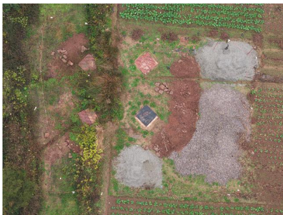
通杨 \pi 接线路 N11 塔塔基及塔基施工场地未开展表土剥离及堆存保护，未采取苫盖措施
