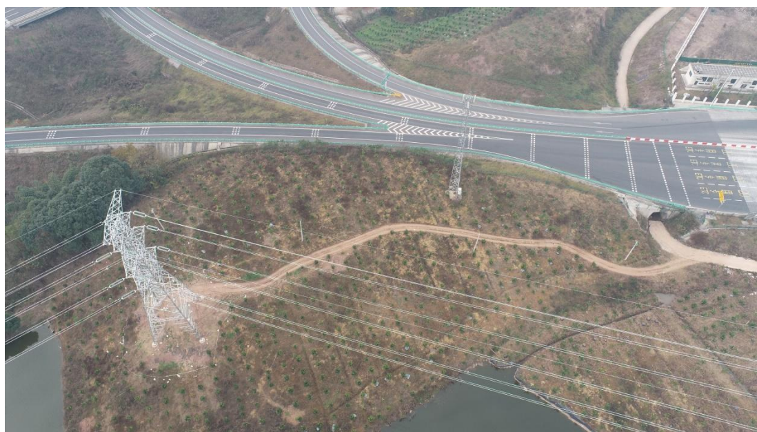
G34 塔基及施工道路（组塔完成后未整地绿化）
