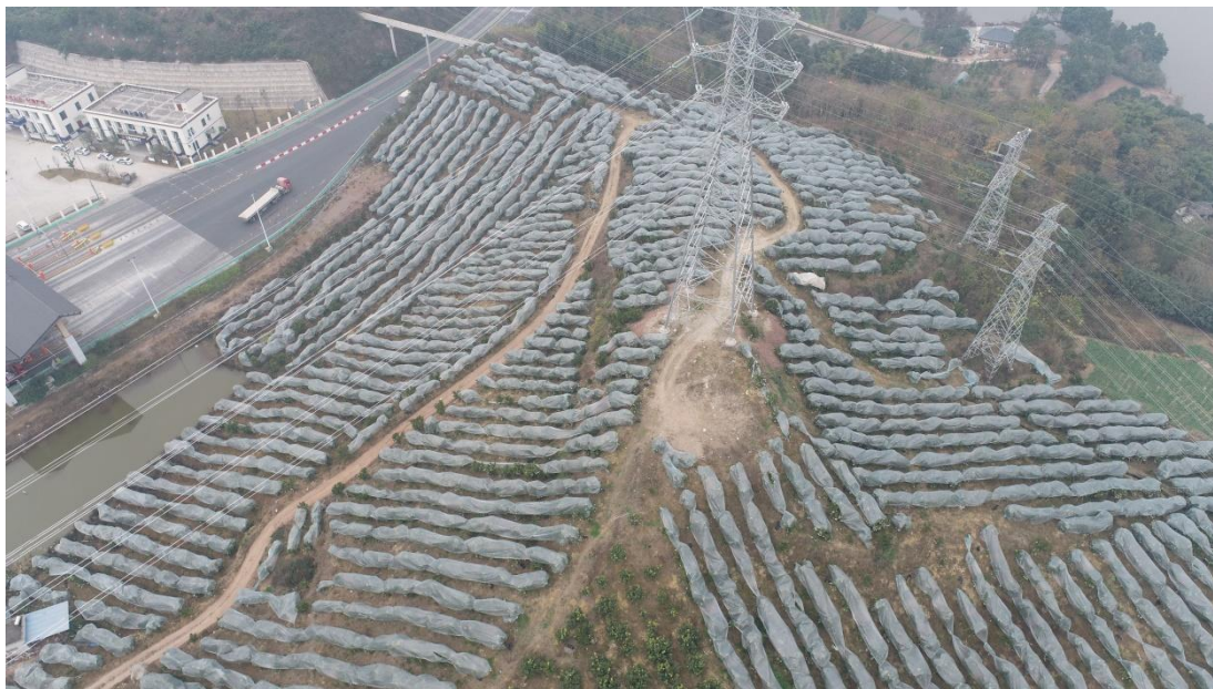
G35 塔基及施工道路（组塔完成后未整地绿化）
