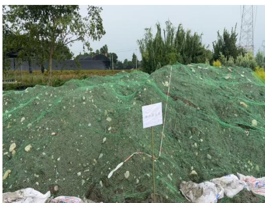
图8-2塔基区表土剥离及保护措施
