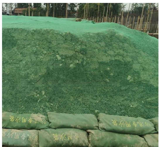
图8-3 变电站区表土剥离后密目网苫盖
