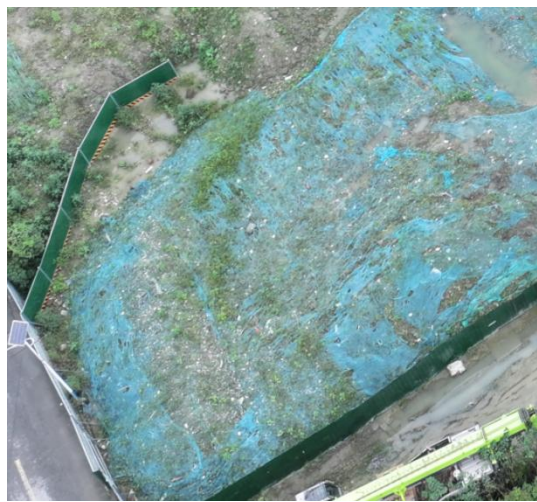
图8-4 变电站区临时堆土密目网苫盖
