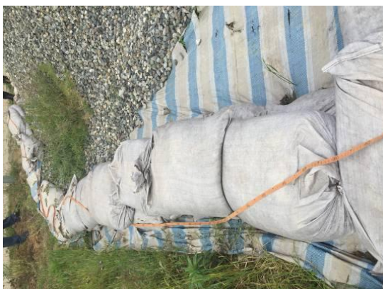
图8-2塔基区彩条布和袋装土拦挡
