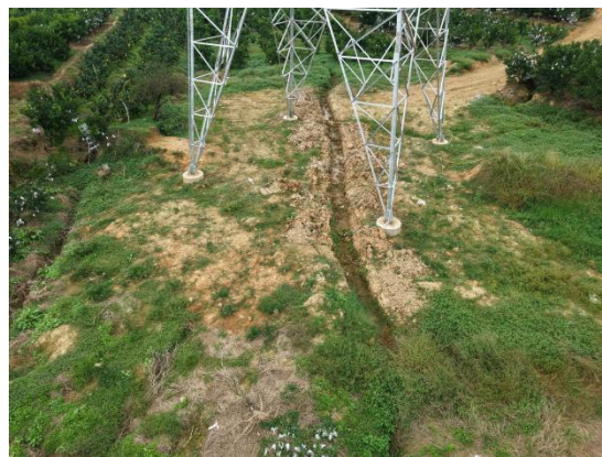
图5-1 ND6施工完成后场地平整不到位 图5-2 ND17开挖堆土随意堆放
