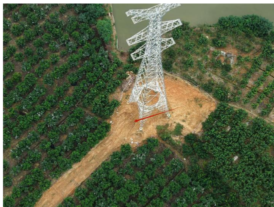
图5-1 ND6施工完成后场地平整不到位 图5-2 ND17开挖堆土随意堆放
