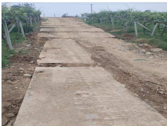
图8-1 施工道路铺设钢板
