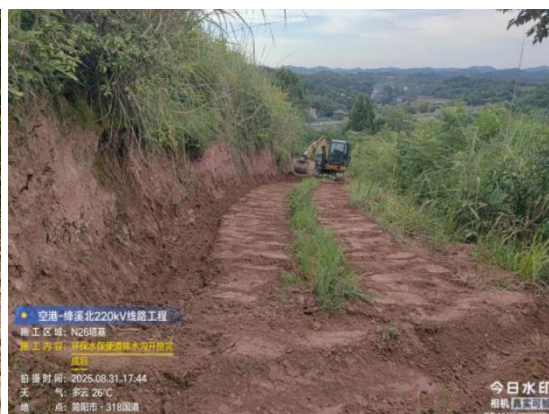
图8-6 施工道路修筑临时排水沟
