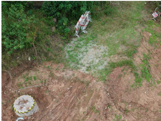
图5-1 N29塔基砂石料清理不到位
