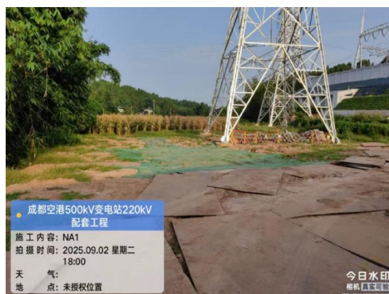
图8-7 施工场地铺设钢板
