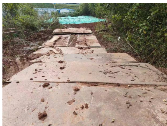
图8-3 塔基区采用钢板铺设
