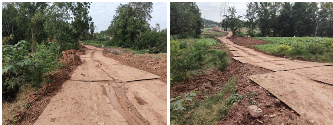
图8-9 图8-10塔基区完成场地整治
