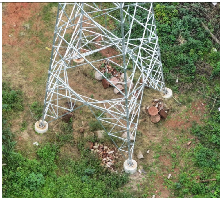
NA44塔基内施工垃圾未清理
