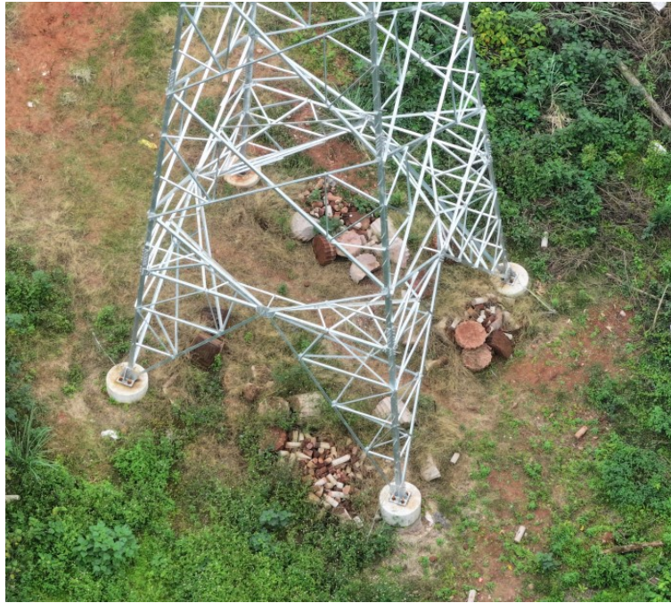
NA44塔基内施工垃圾未清理
