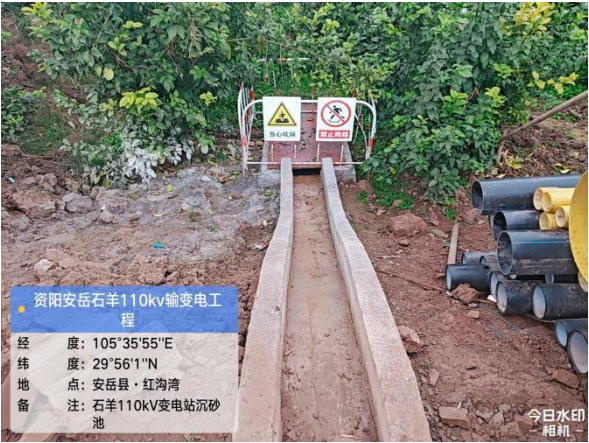
变电站临时排水沟及沉沙池
