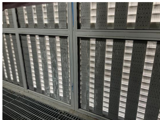
图 16 主变压器室消声百叶
