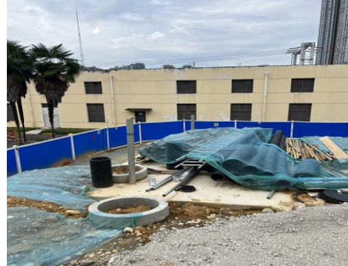
图 57 施工区域围挡+遮盖
