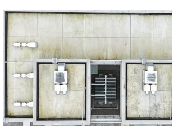
配电装置楼顶户外消音出风口
