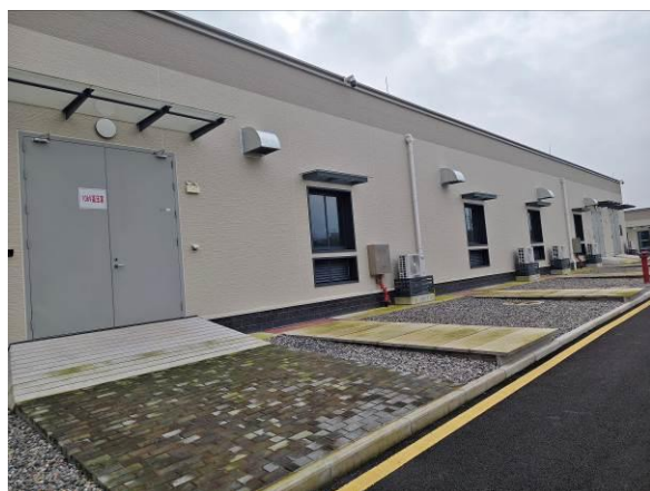
配电装置楼户外消音通风口
