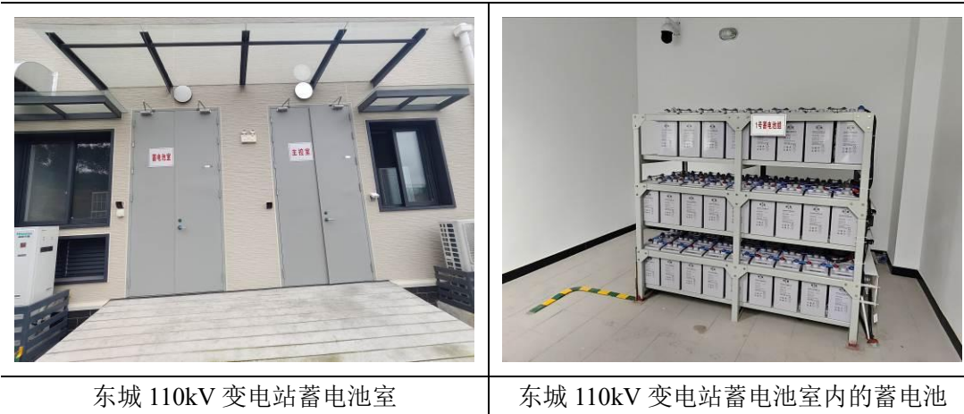
图 8-7 东城 110kV 变电站蓄电池室及蓄电池组
