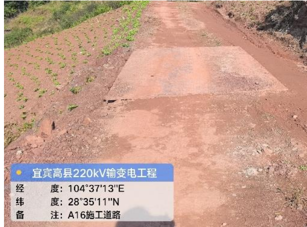
汽运道路铺设钢板
