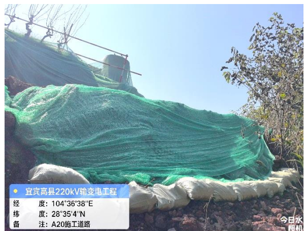
汽运道路边坡土袋拦挡、临时苫盖
