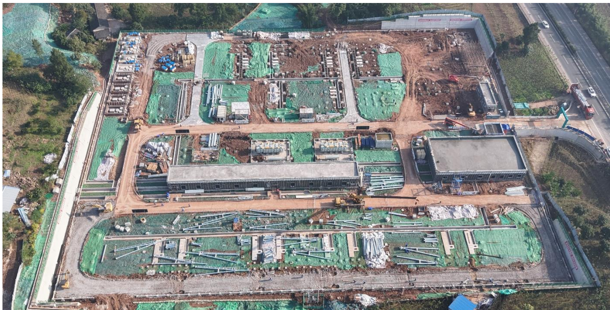
高县 220kV 变电站临时苫盖
