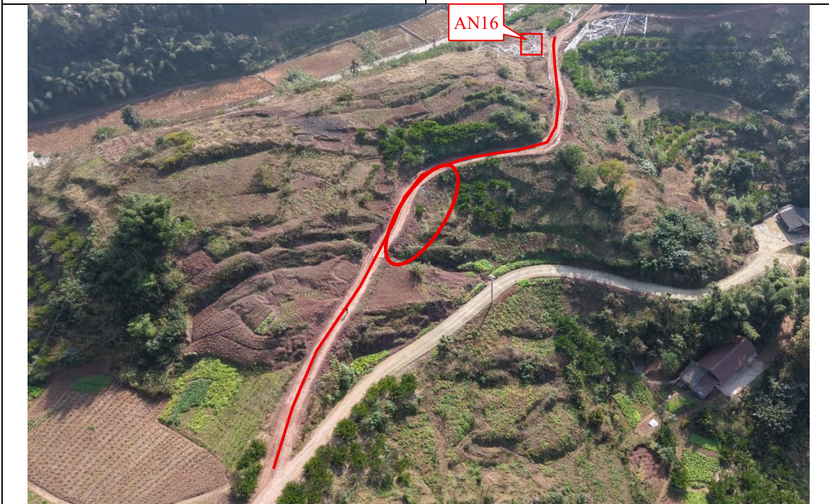
AN16 汽运道路未剥离表土，道路内侧未设临时排水沟，外侧坡面未采取临时拦挡、苫盖措施
