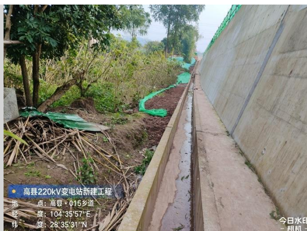
混凝土排水沟 (东侧)
