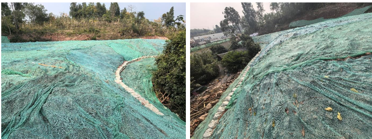
站外东北侧临时堆土区域土袋拦挡、临时苫盖
