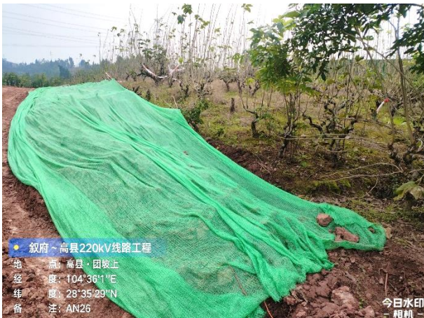
汽运道路表土剥离、临时苫盖
