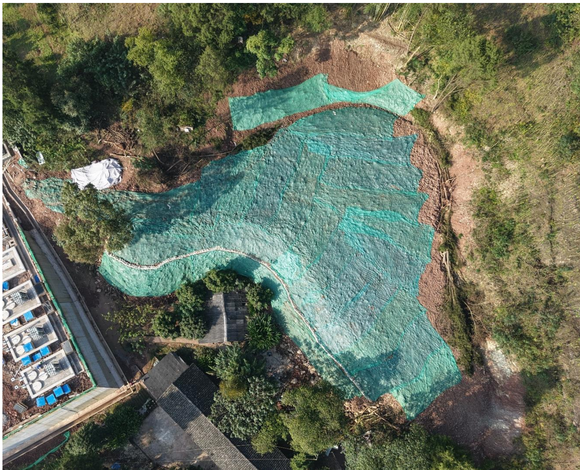
高县 220kV 变电站东北侧临时堆土区域土袋拦挡、临时苫盖
