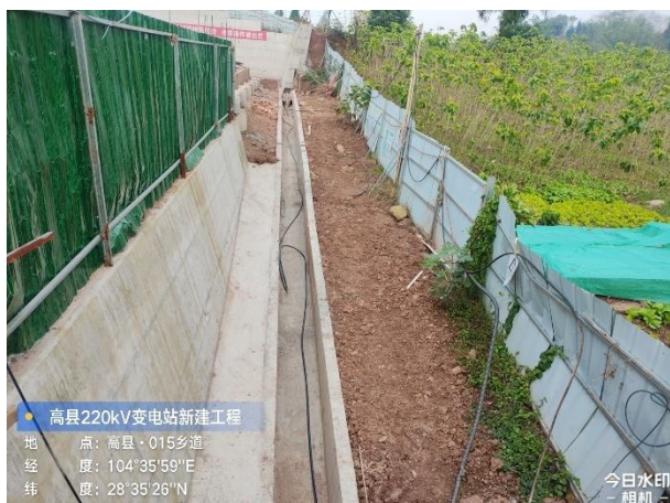
混凝土排水沟 (南侧)
