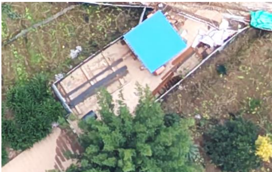
钢筋及木工加工场临时苫盖
