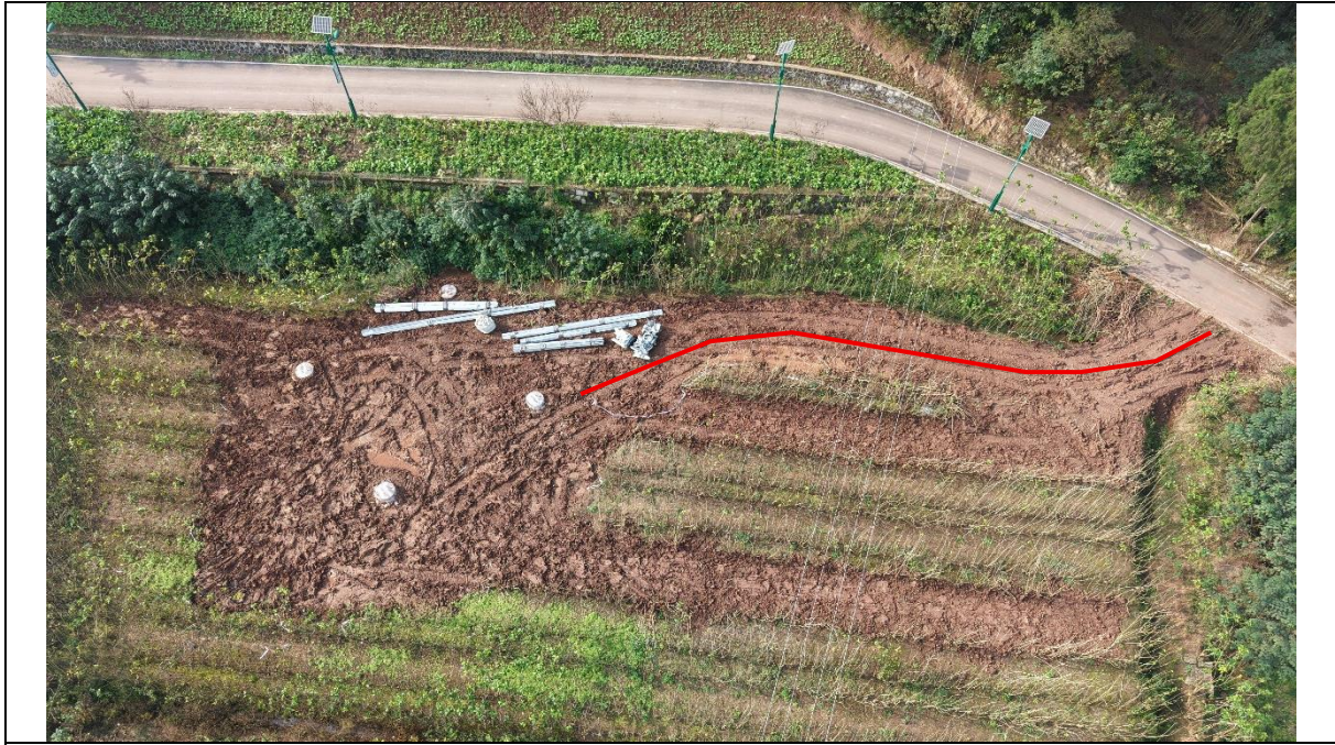
BN6 汽运道路未落实表土铺垫保护（铺设钢板）措施
