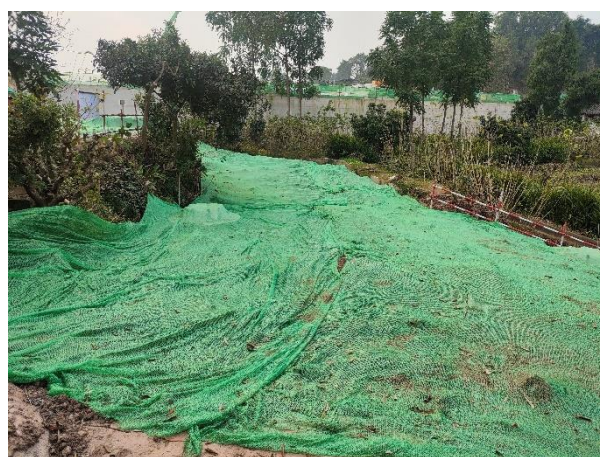
塔基及其施工临时占地表土剥离、土袋拦挡、临时苫盖
