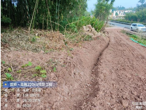
汽运道路临时排水沟
