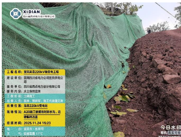
汽运道路边坡临时苫盖、临时排水沟
