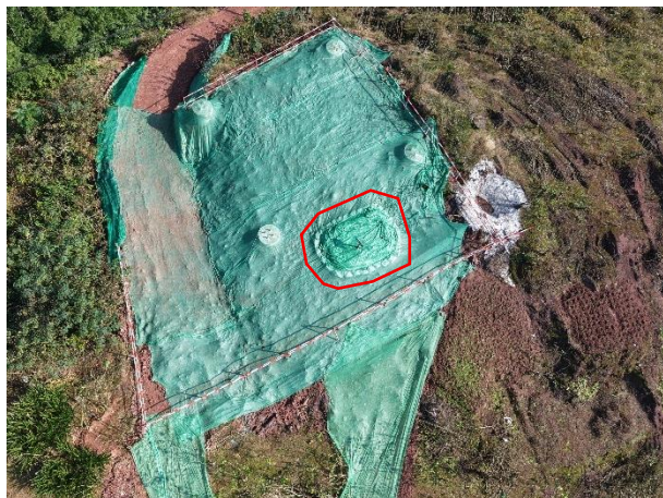
塔基及其施工临时占地表土剥离、土袋拦挡、临时苫盖
