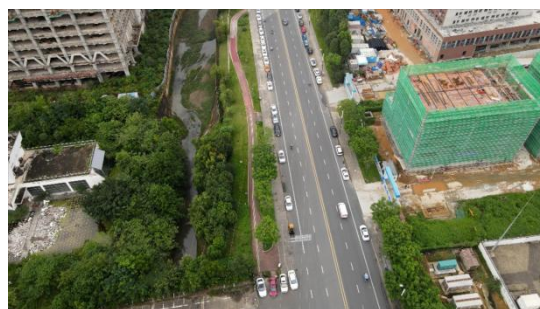
110kV 面桃线 17#~18#杆附近（香樟、小叶榕）
