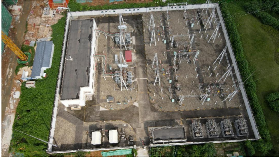
图 3-1 已建桃园 110kV 变电站现状
