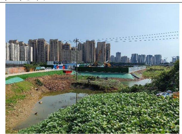
进站道路区防雨布遮盖、车辆冲洗站、三级沉淀池
