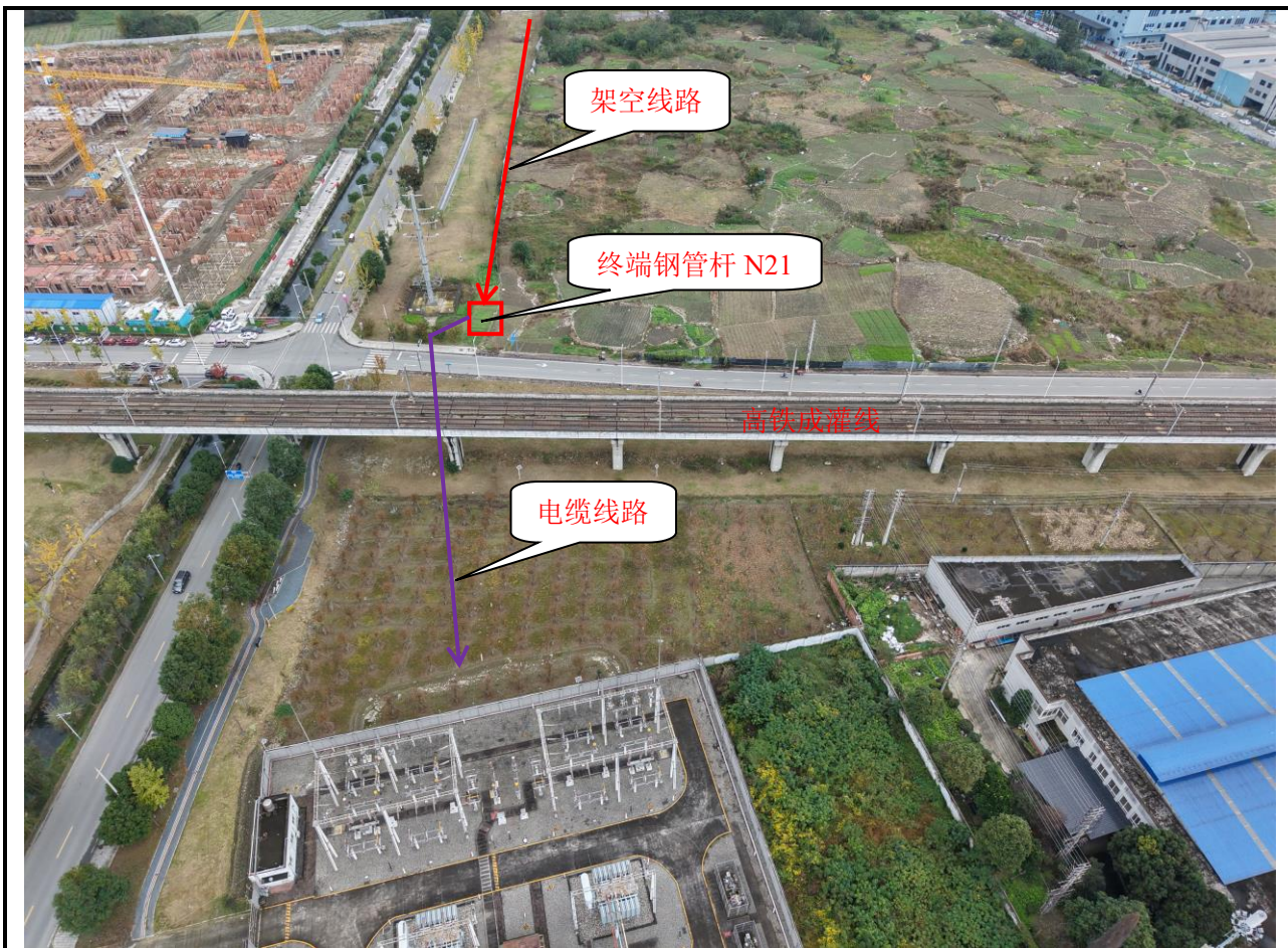
安龙 110kV 变电站端进行情况
