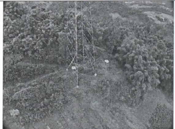
塔基施工现状
