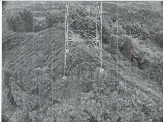
塔基施工现状
