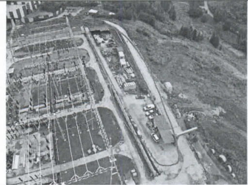
施工场地现状
