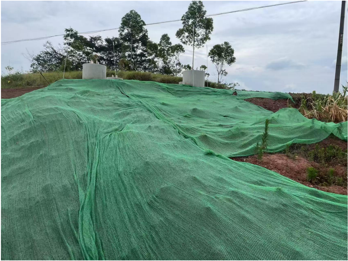
G33 塔基施工场地密目网苫盖
