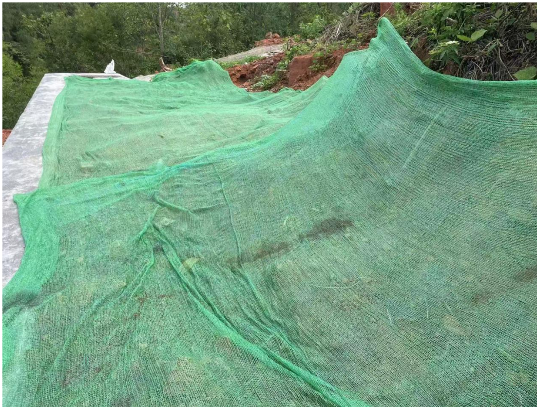
长滩 35kV 变电站边坡密目网苫盖
