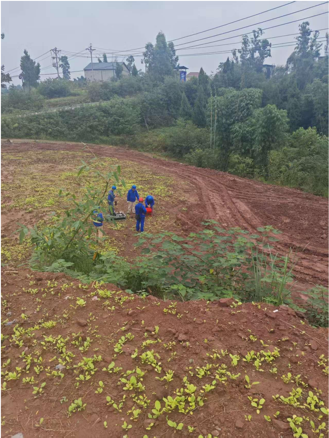
施工临时场地区（变电）场地植被复绿
