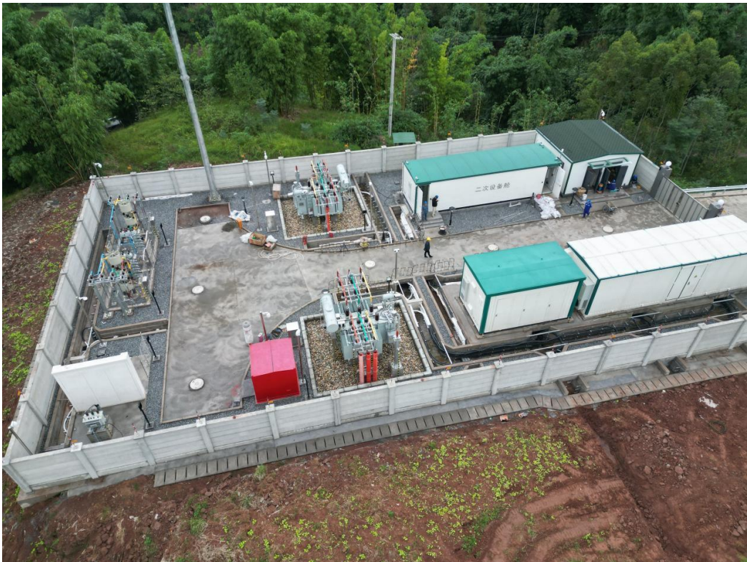
长滩 35kV 变电站站内配电装置碎石铺设及站外边坡绿化
