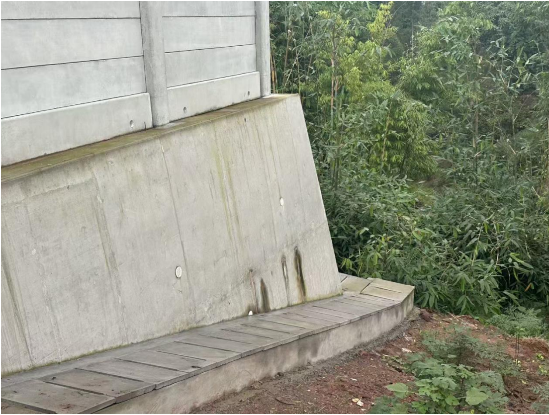
长滩 35kV 变电站站外排水沟 1
