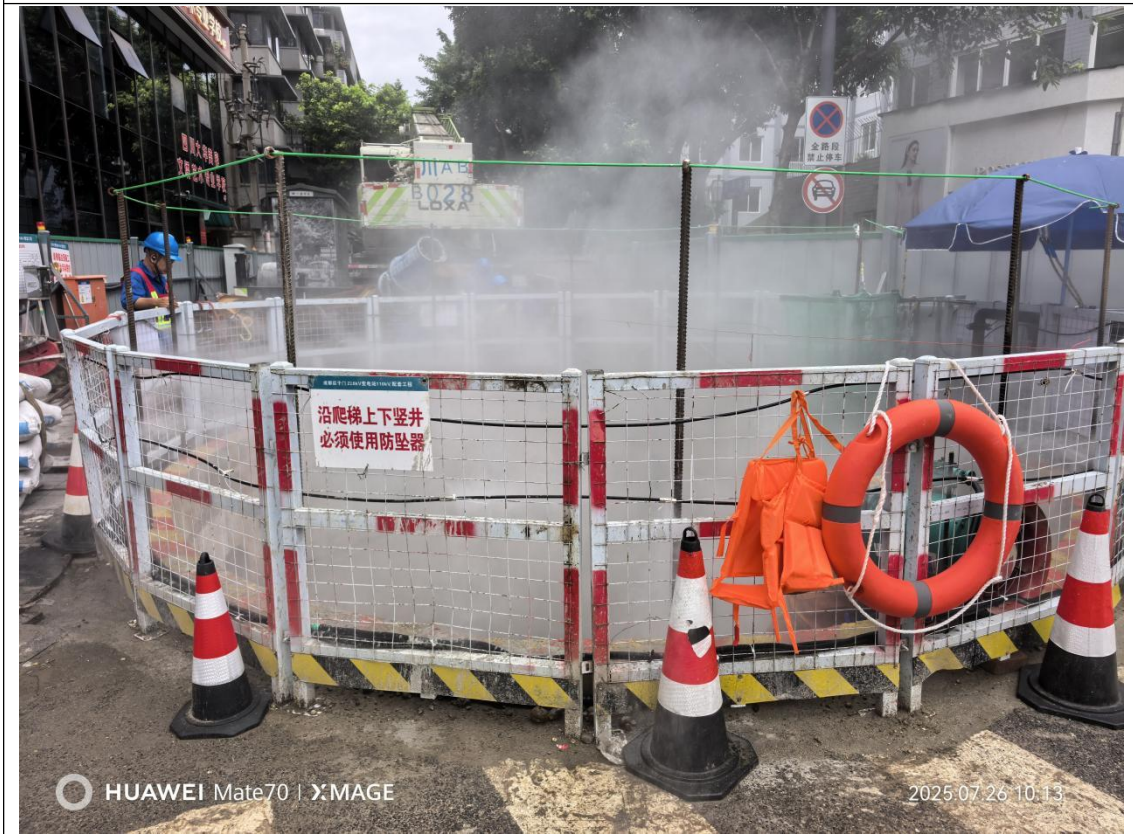
工作竖井施工
