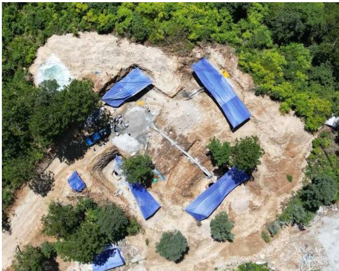
新建 1026G 塔基施工期临时遮盖
