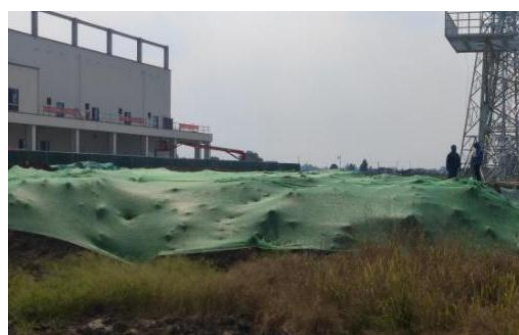
高埂—赵塔电缆施工区临时遮盖
