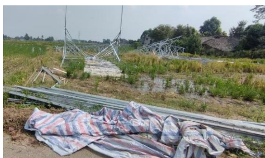
苏场—邛崃 N5 塔位施工场地铺垫隔离
