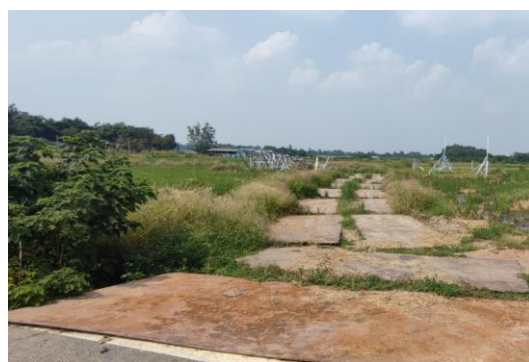
苏场—福田 N6 塔位施工道路铺设钢板
