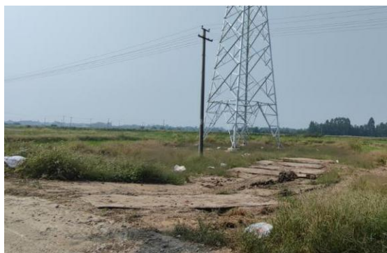
庄园—解林 N18 塔位施工道路铺设钢板
