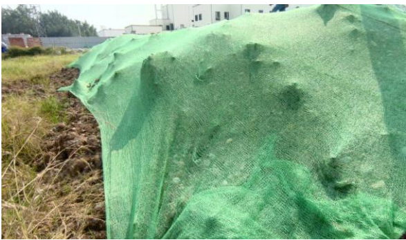
高埂—赵塔电缆施工区表土剥离
