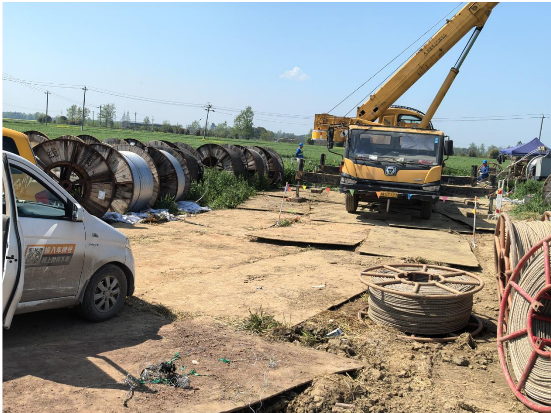
邓寿安支线 \pi 入高埂 110kV 线路工程 N18 塔位牵张场
