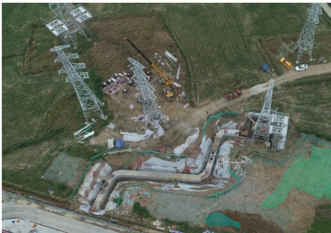
高埂—赵塔 110kV 线路工程新建电缆通道
