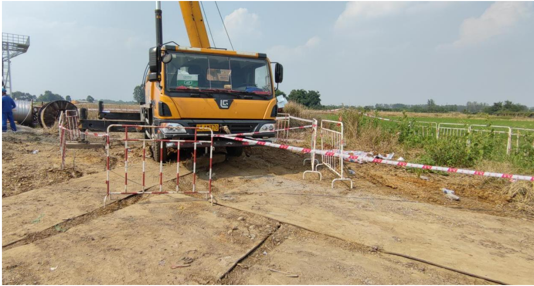
高埂—赵塔 110kV 线路工程 N1 塔位牵张场
