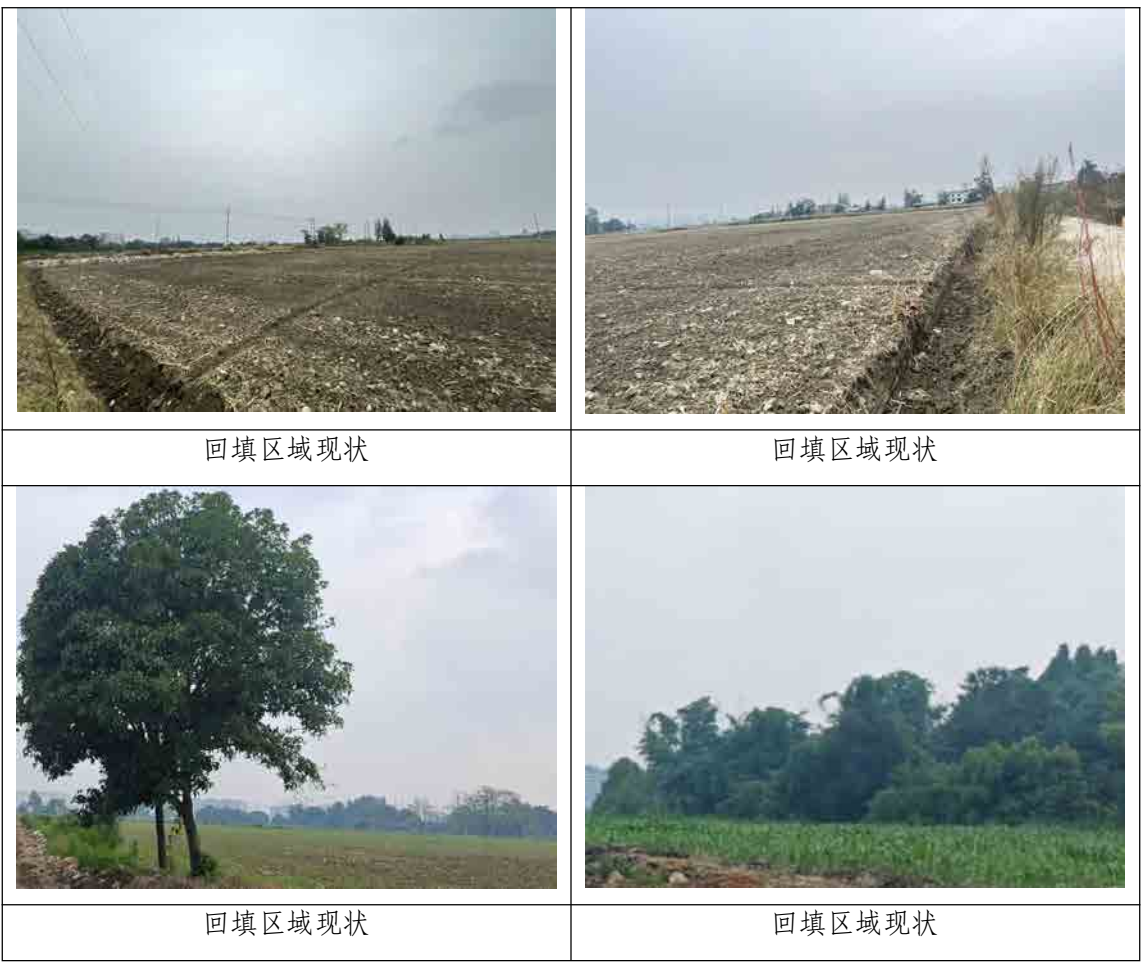
图 1-4 西华街道环城生态区土地搬迁流转旧房拆除、建渣清运及场地覆盖采购项目 现状照片
