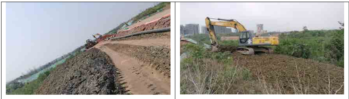
图 1-3 西华街道环城生态区土地搬迁流转旧房拆除、建渣清运及场地覆盖采购项目 回填时照片（由施工单位提供）
