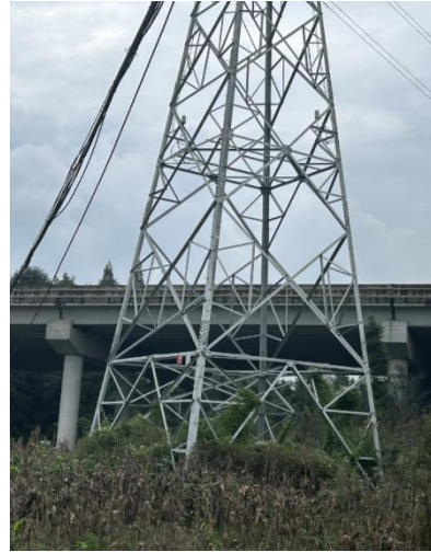
J37#塔基及跨越场
