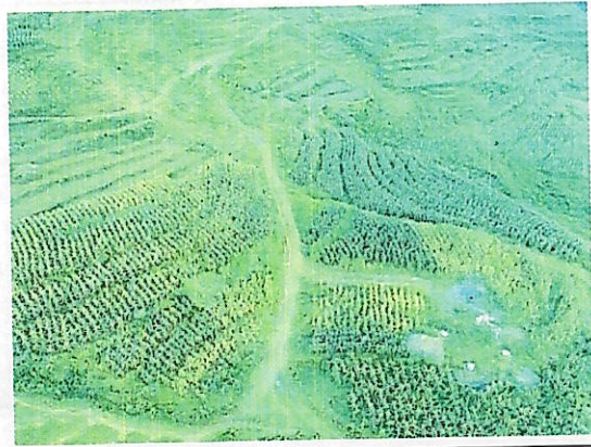
NA124 施工道路（人抬道路）
