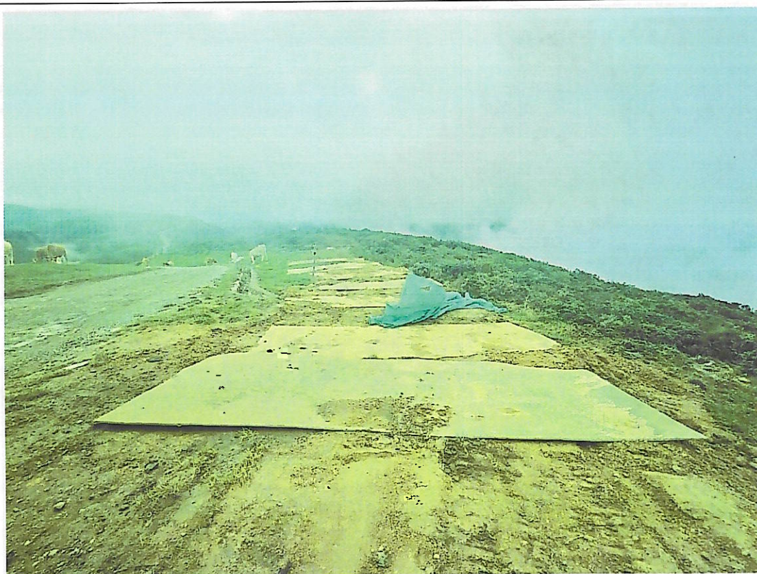
NA31 施工道路铺设钢板
