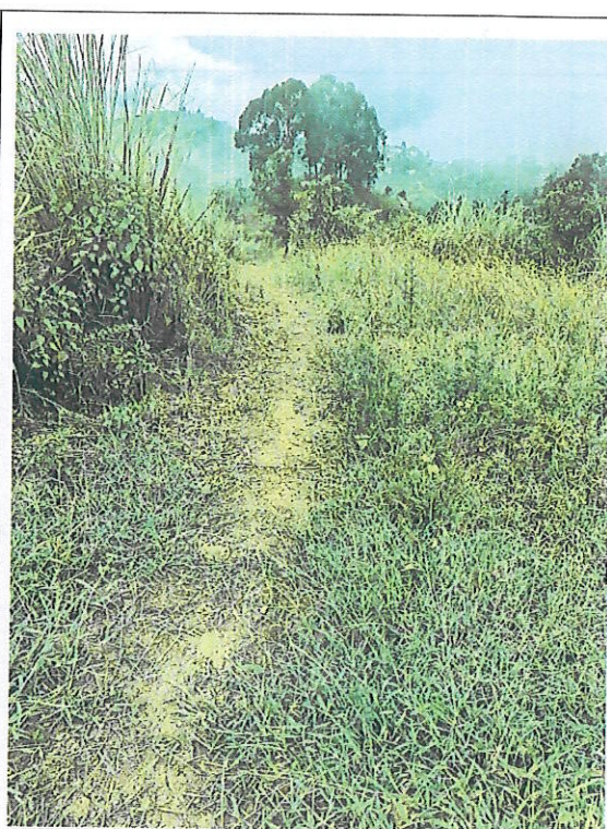
NB116 施工道路
