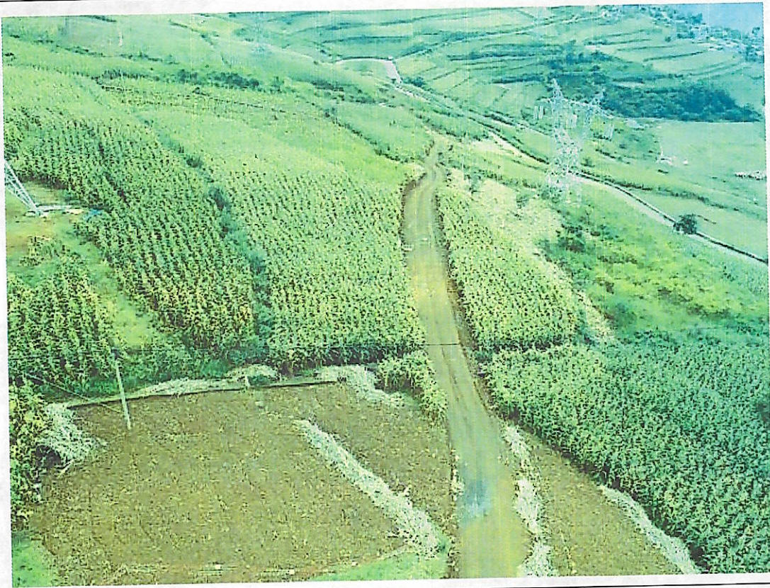
NA135 施工道路
