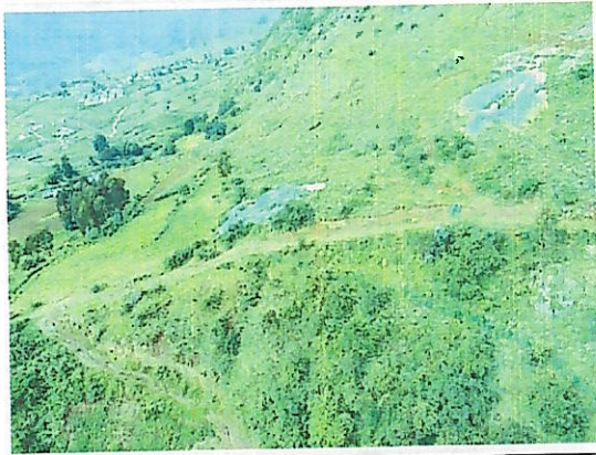
NA69 施工道路
