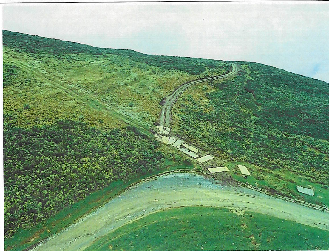
NB33 施工道路铺设钢板
