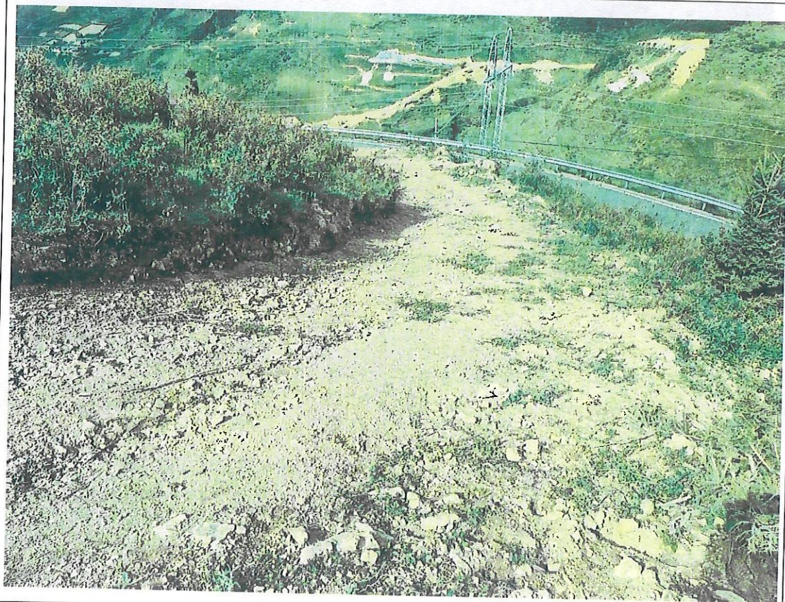
NA35 施工道路（人抬道路）
