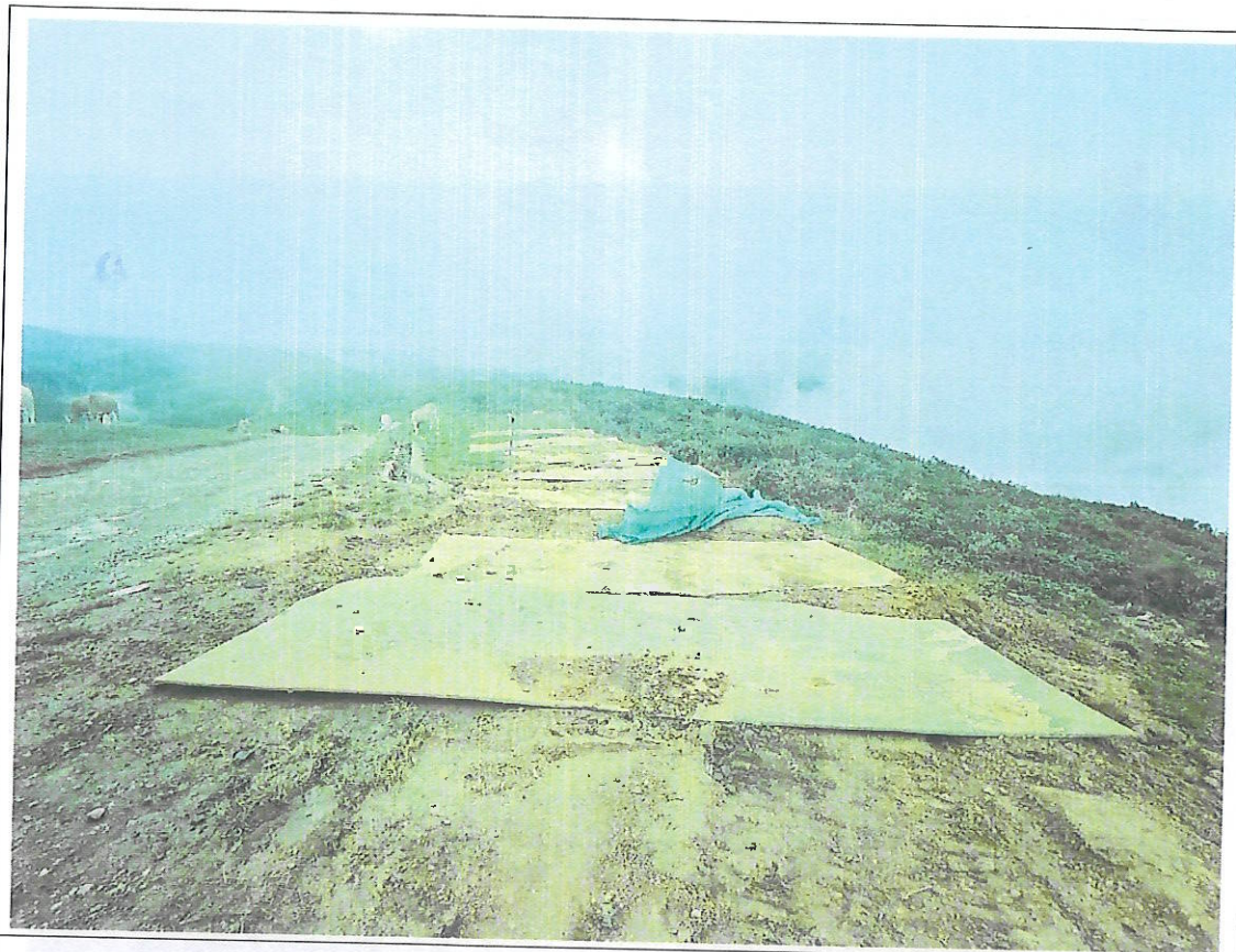
NA31 施工道路铺设钢板
