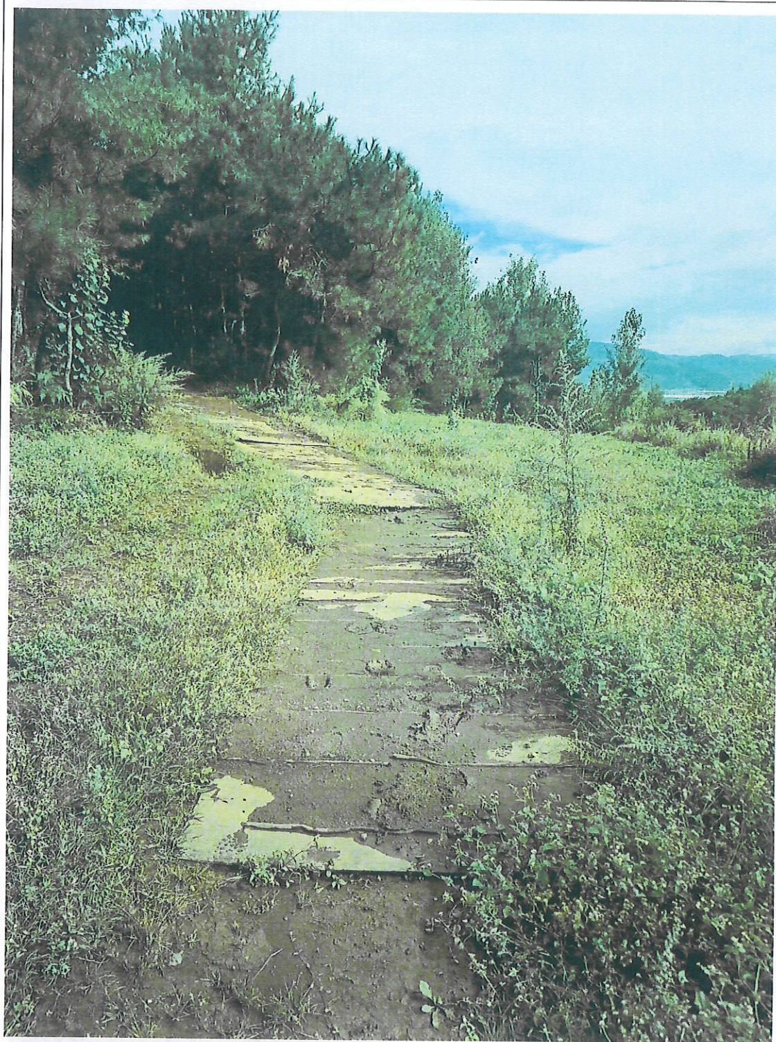
NA4 施工道路钢板铺垫
