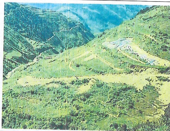
NB37 塔位下边坡增加临时遮盖、挡泥板挡护措施
