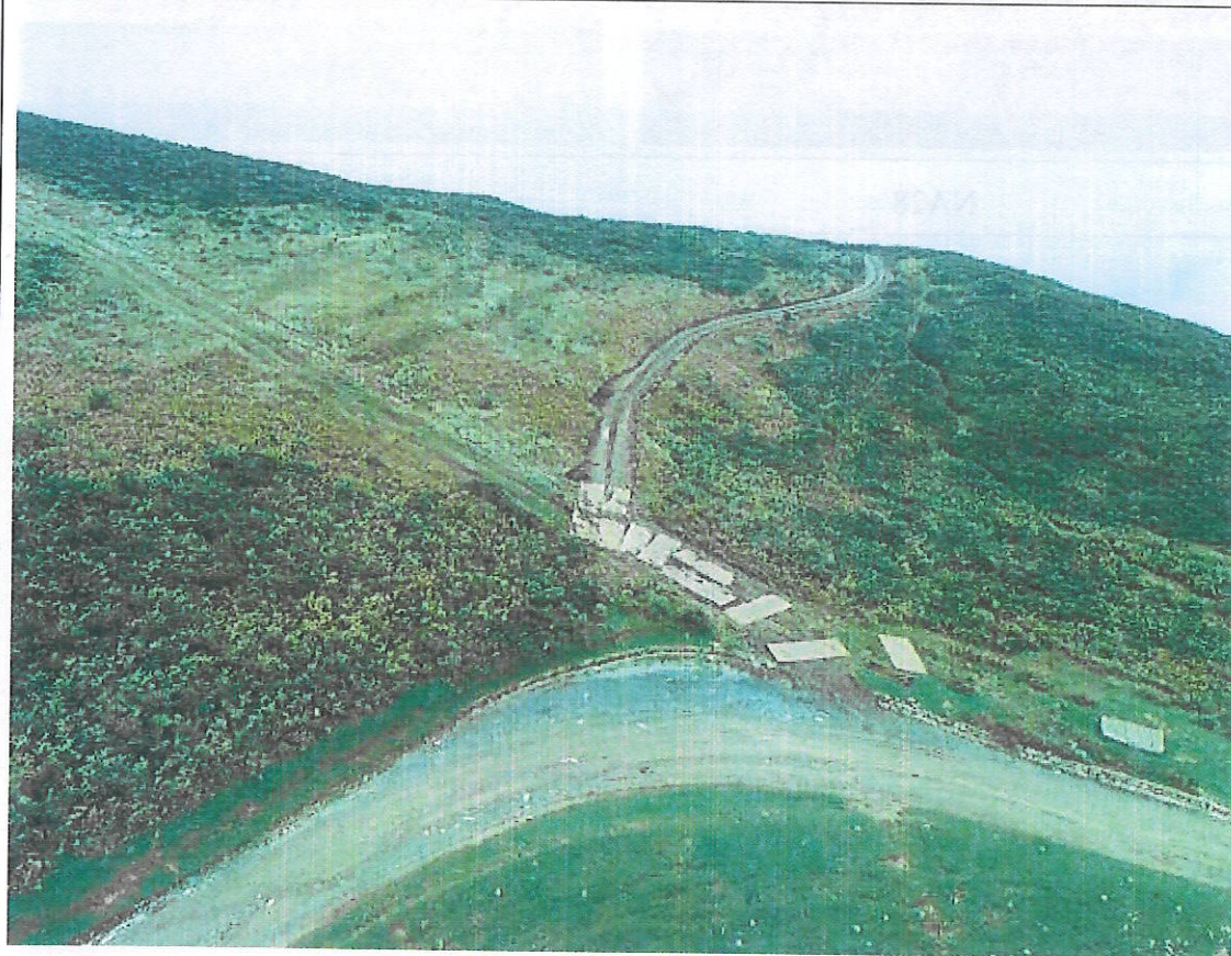
NB33 施工道路
