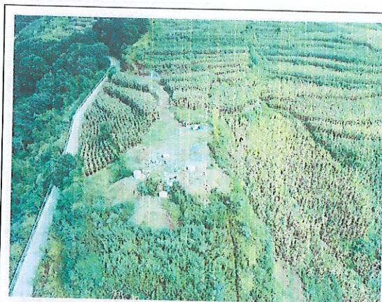
NB122 清除施工临时场地存在的浆砌石等建筑垃圾、土地整治
