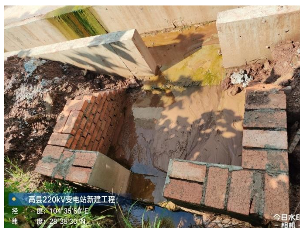
站外临时沉沙池
