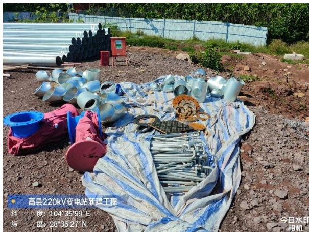
站外施工临时场地区塑料布铺垫
