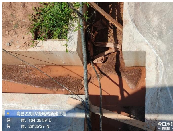
进站道路排水沟、沉沙池
