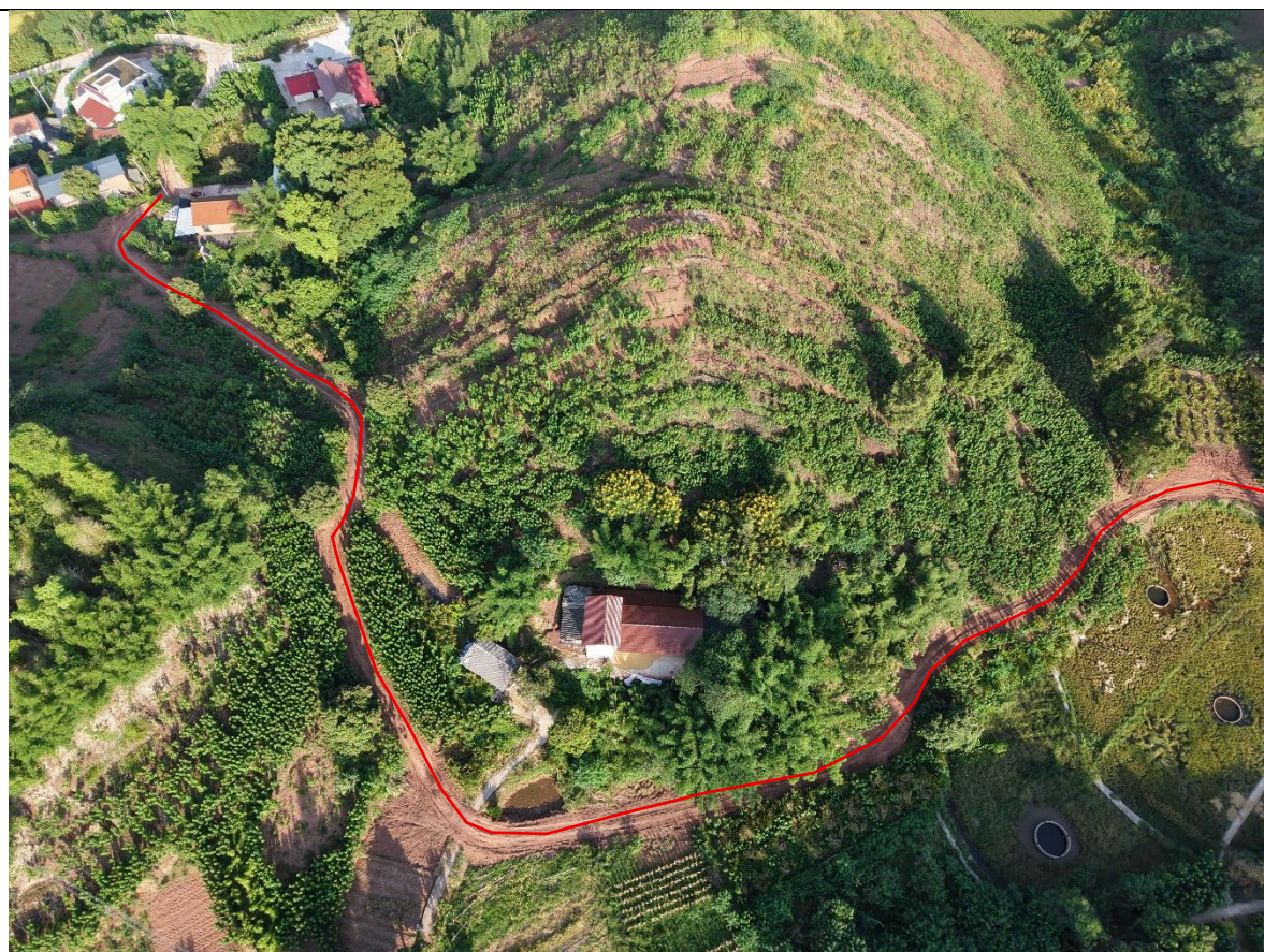
N23、B4 汽运道路 汽运道路未进行表土剥离，内侧未设置临时排水沟，路面临时铺垫措施未落实
