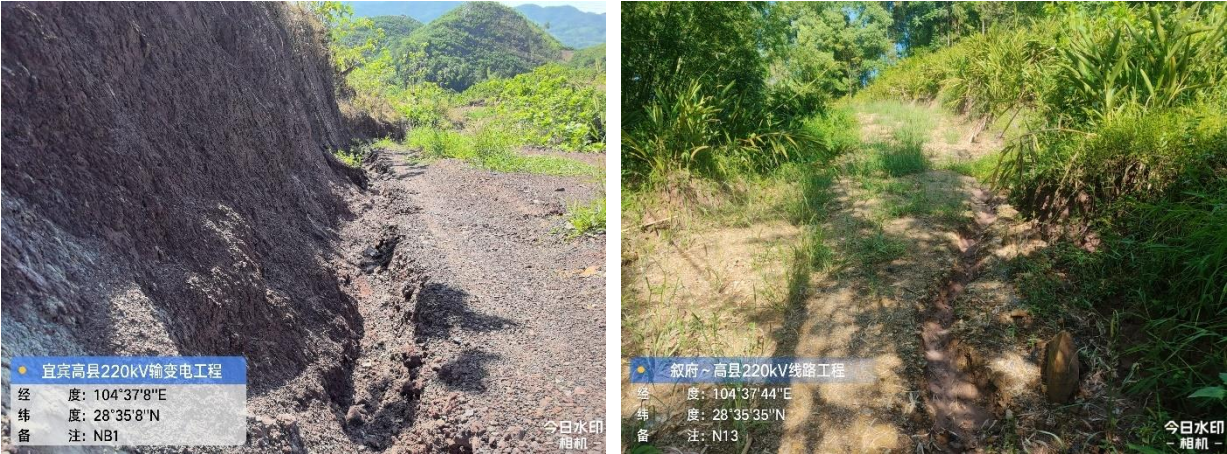
汽运道路临时排水沟
