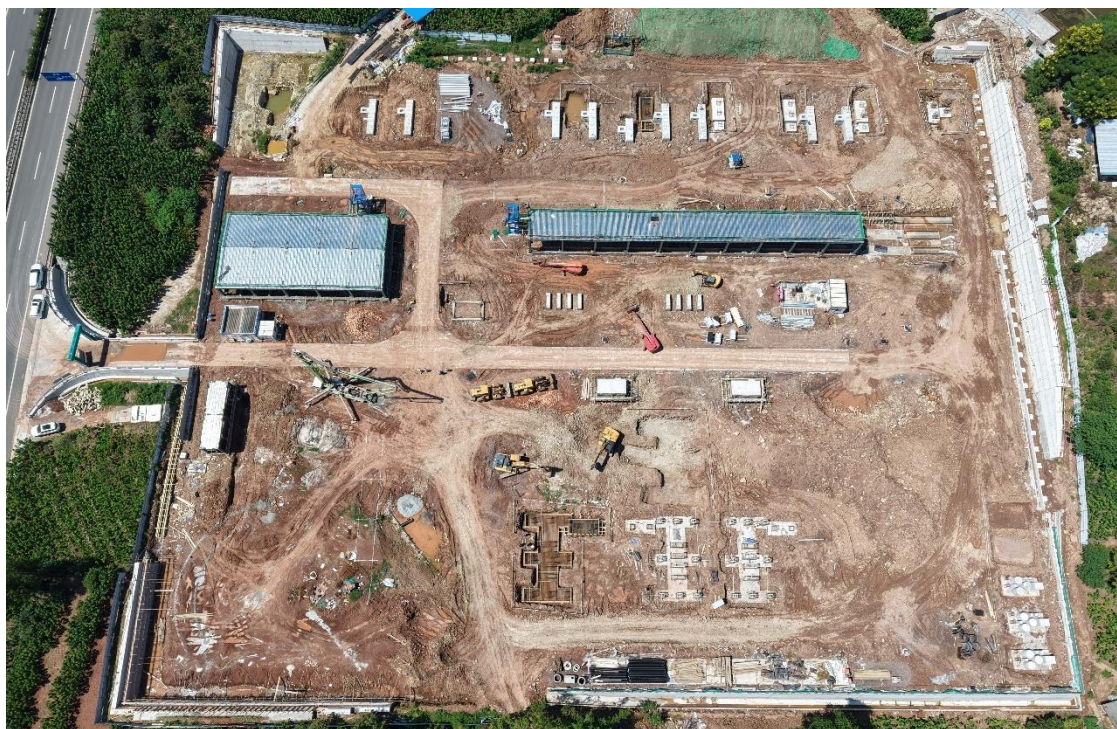
高县 220kV 变电站施工现状
