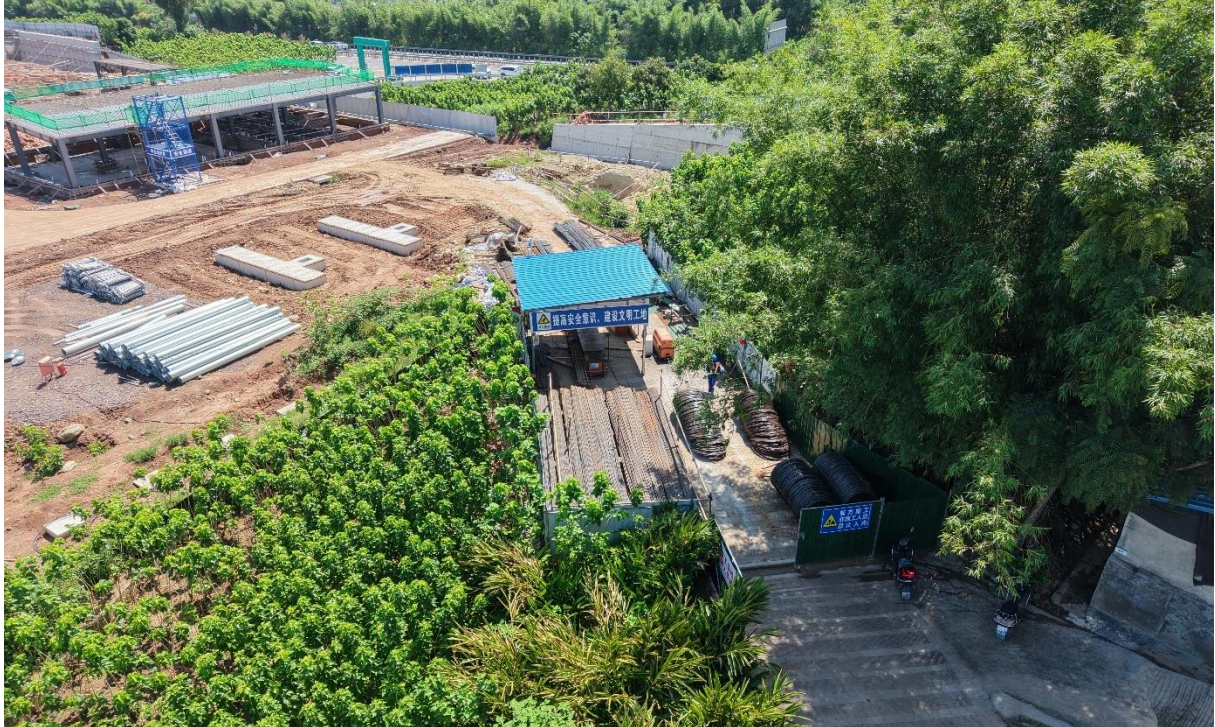
站外施工临时场地区现状
