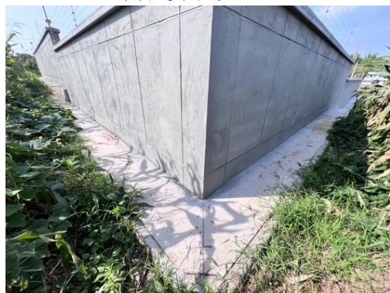
站外巡检通道现状
