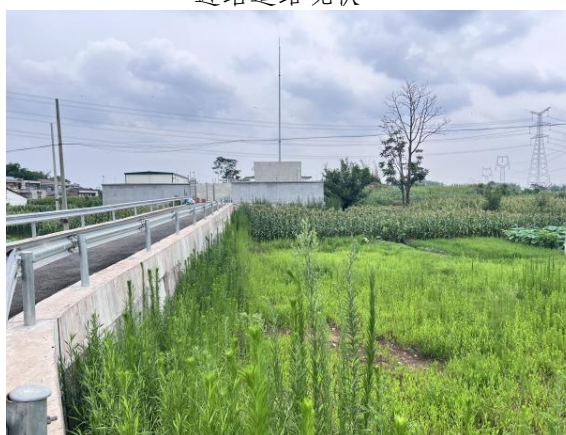
进站道路右侧现状
