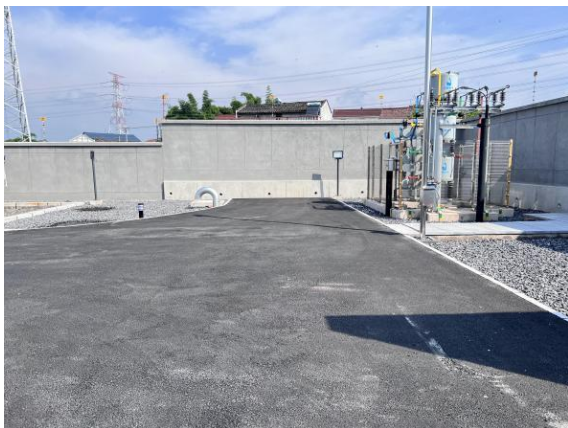
站内道路现状
