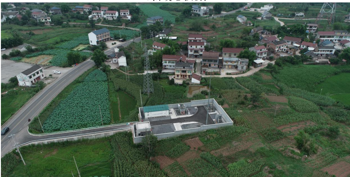
刘家变电站现状
