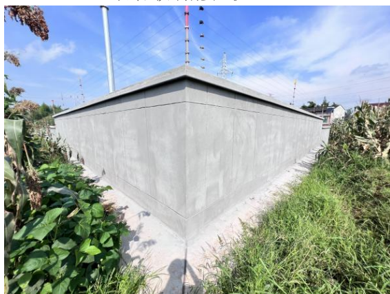
站外巡检通道现状
