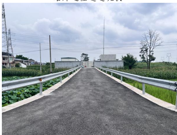
进站道路现状
