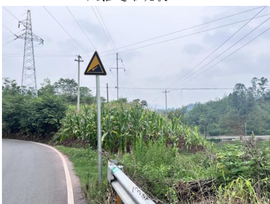
5号塔基牵张场场地恢复现状
