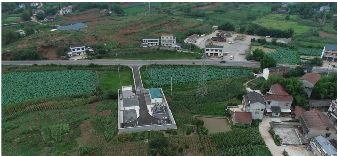
刘家变电站现状
