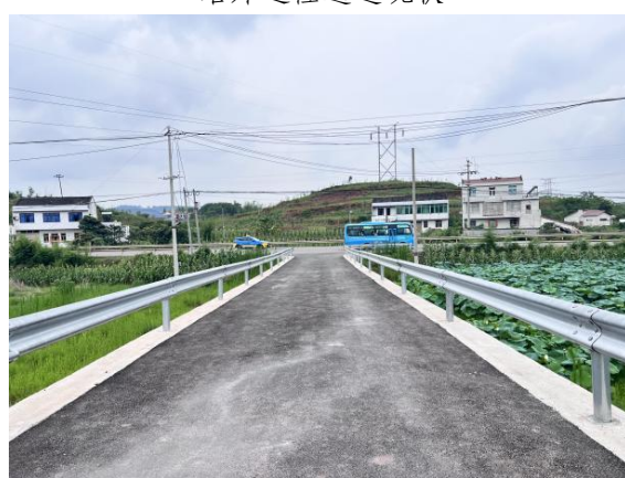
进站道路现状
