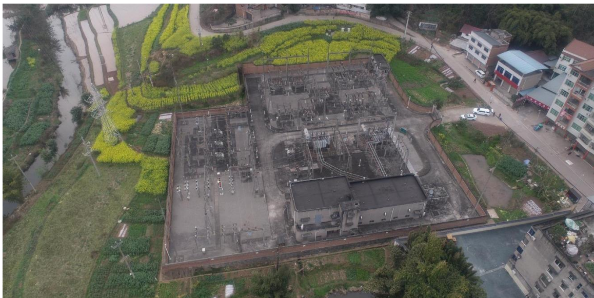
大观 110kV 变电站 35kV 间隔扩建工程
