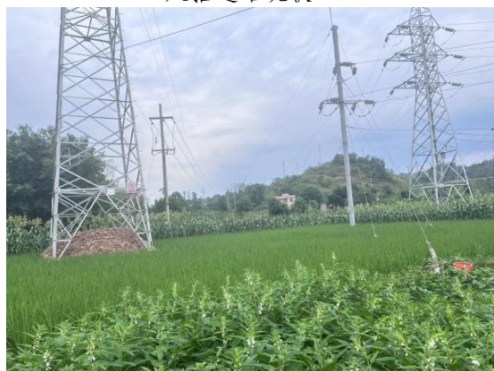
1号塔基牵张场场地恢复现状
