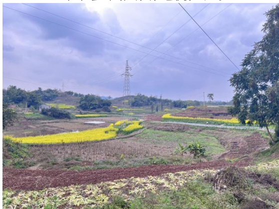
21号塔基牵张场场地恢复
