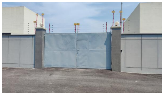
金坪变电站大门现状
