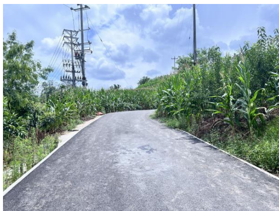
进站道路现状
