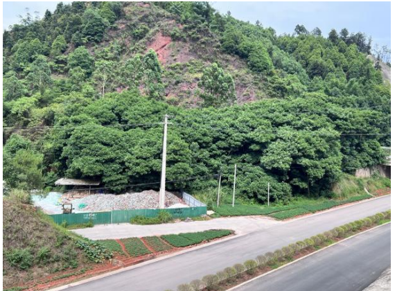
23号塔基牵张场恢复现状
