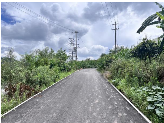
进站道路现状
