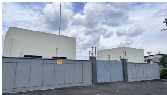
金坪变电站大门现状
