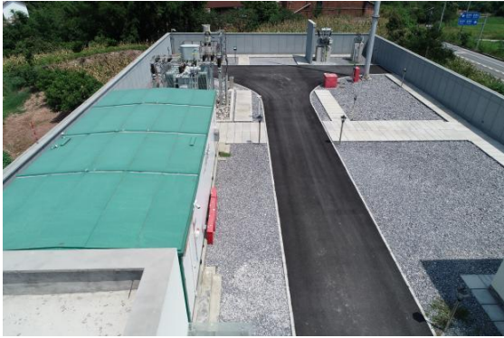
站内道路、碎石铺盖现状
