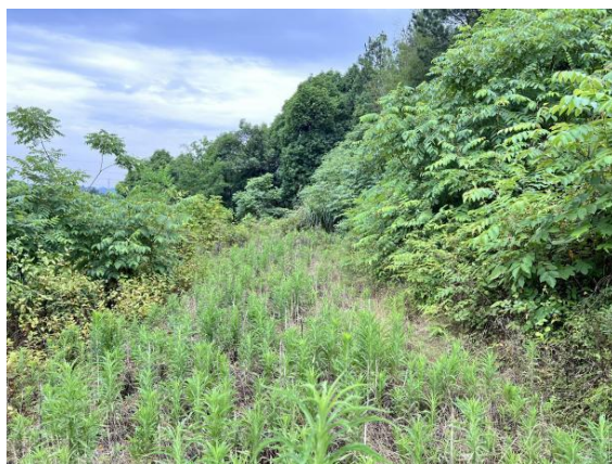
32号施工道路现状
