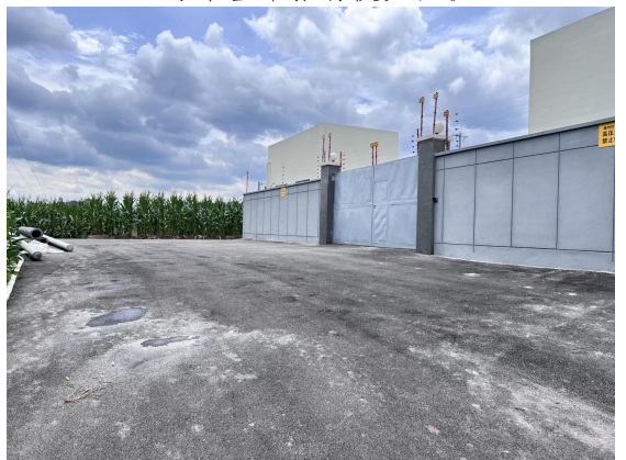
53号塔基牵张场恢复现状
