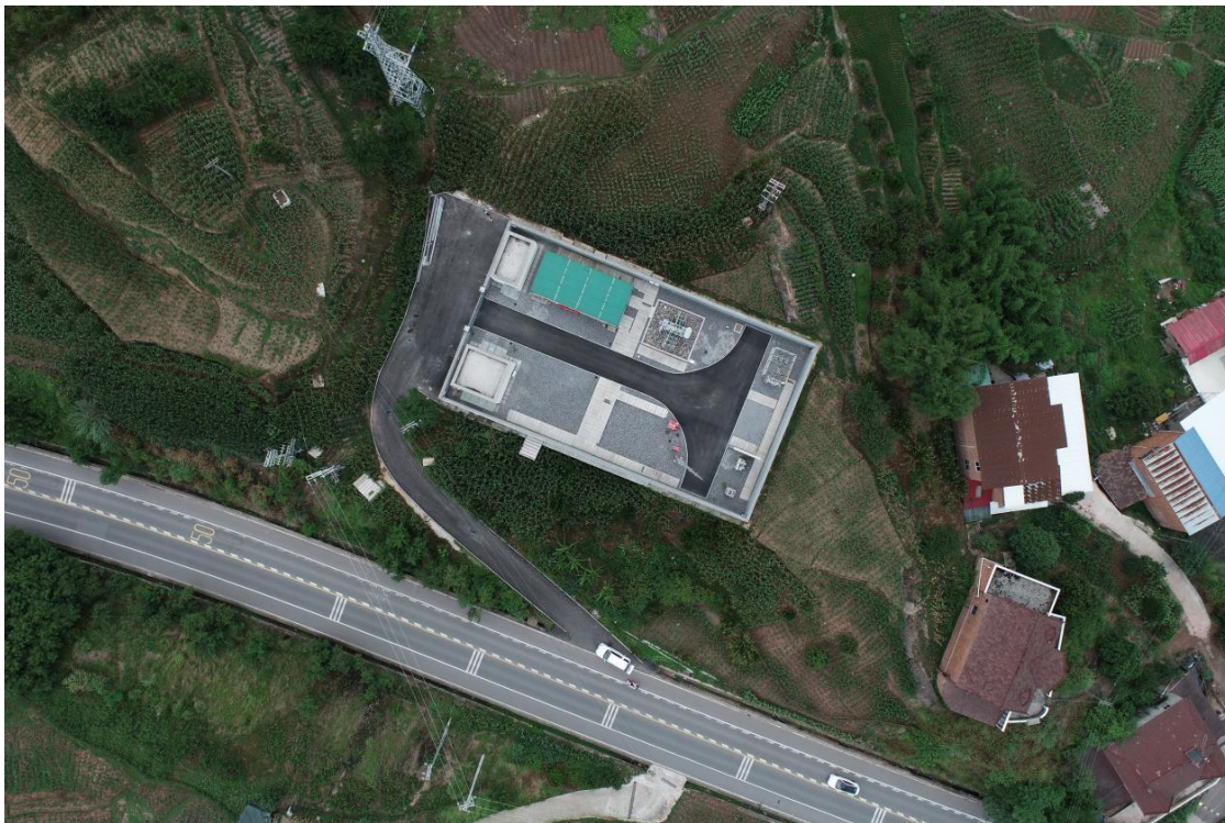
金坪变电站现状
