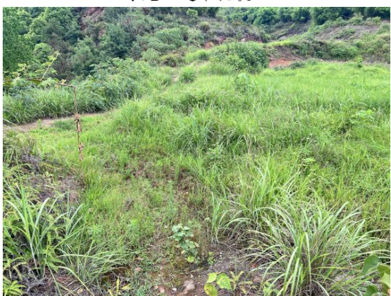
43号施工道路现状
