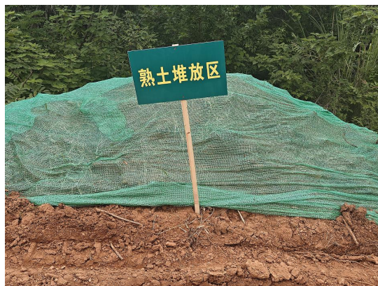
图8-4塔基区表土苫盖
