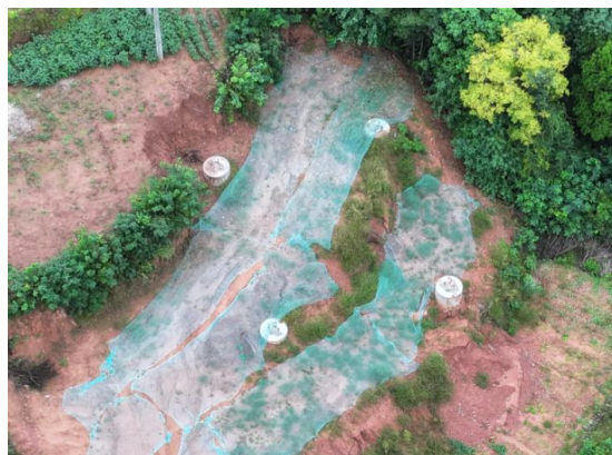
图8-3塔基区及施工道路密目网苫盖
