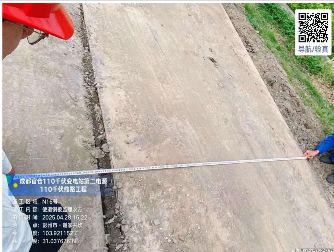
N16 施工便道钢板铺设
