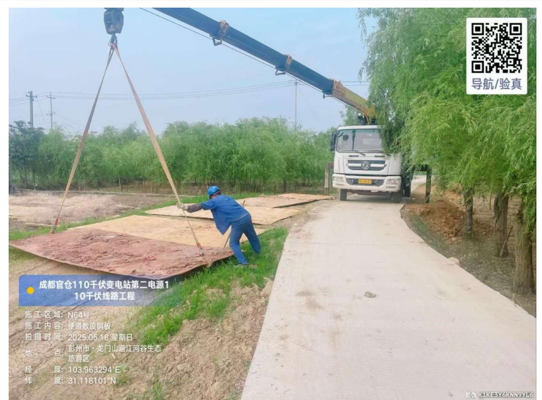
N64 施工道路钢板铺设
