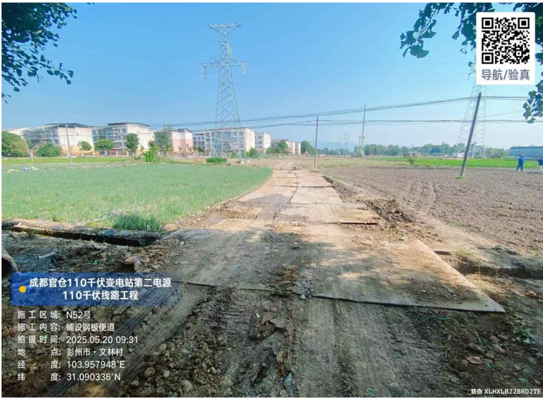
N52 施工道路钢板铺设
