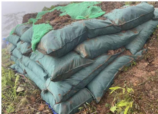
N56 塔基表土剥离及保护
