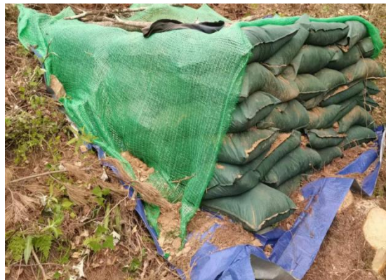
N58 塔基表土剥离及保护
