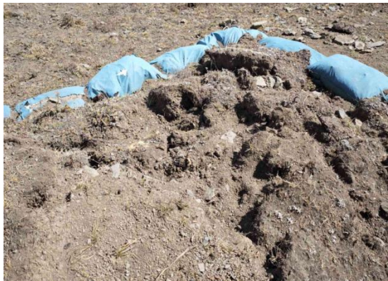
N17 塔基表土剥离及保护
