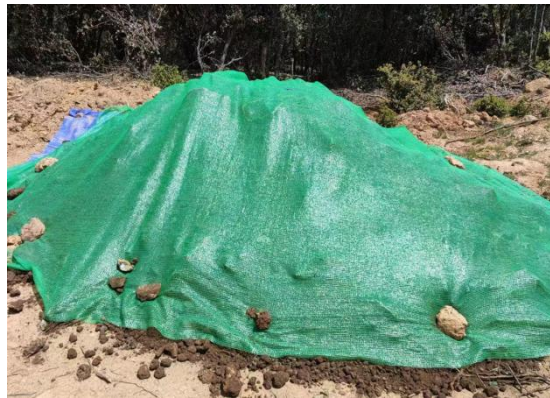
N21 塔基表土剥离及保护
