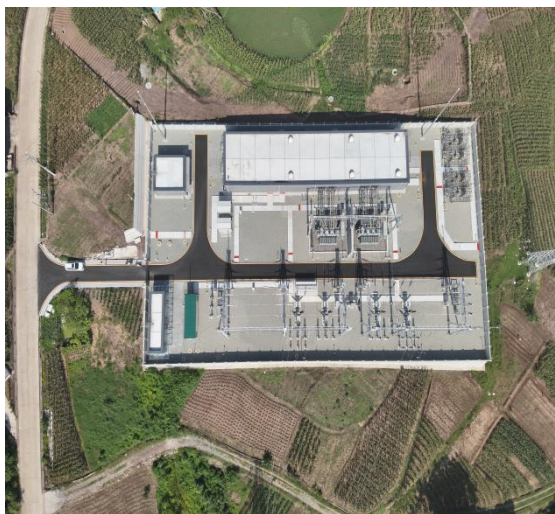
临港 110kV 变电站全景图
