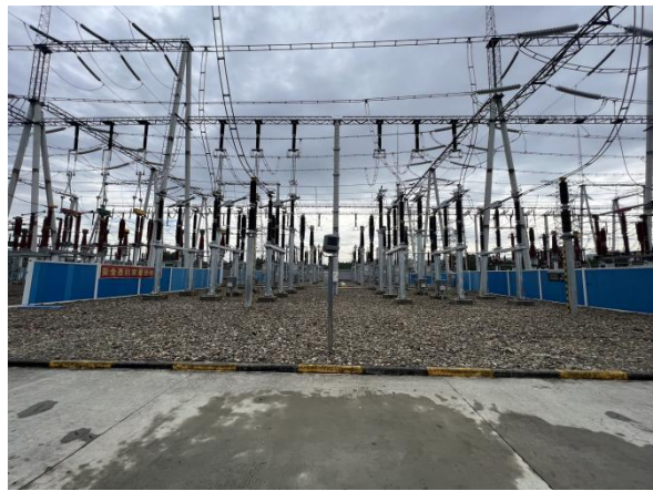
徐家渡 220kV 变电站间隔扩建区域恢复情况
