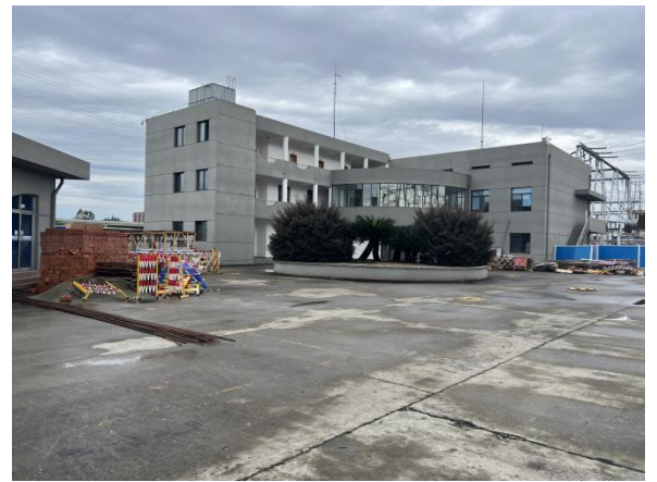
徐家渡 220kV 变电站间隔扩建施工临时占地恢复情况
