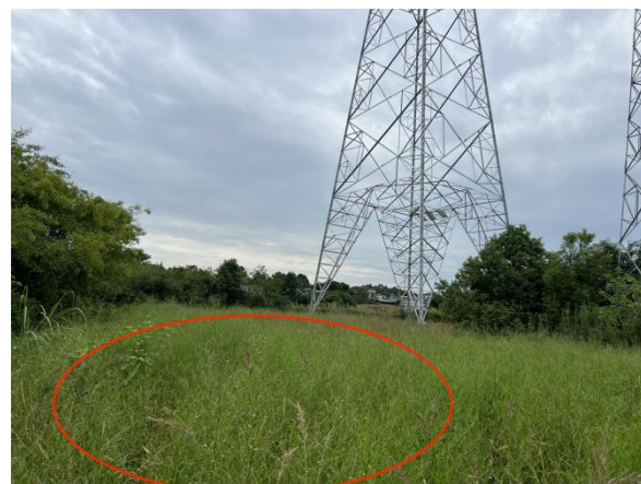
220kV 旗渡一二线 N19 牵张场恢复情况
