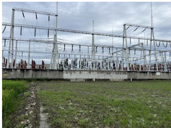
徐家渡 220kV 变电站拆除围墙恢复情况
