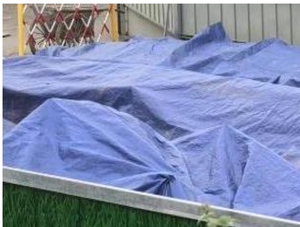
电缆施工区临时遮盖
