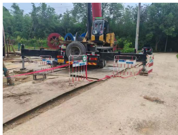
塔基施工区施工便道铺设钢板
