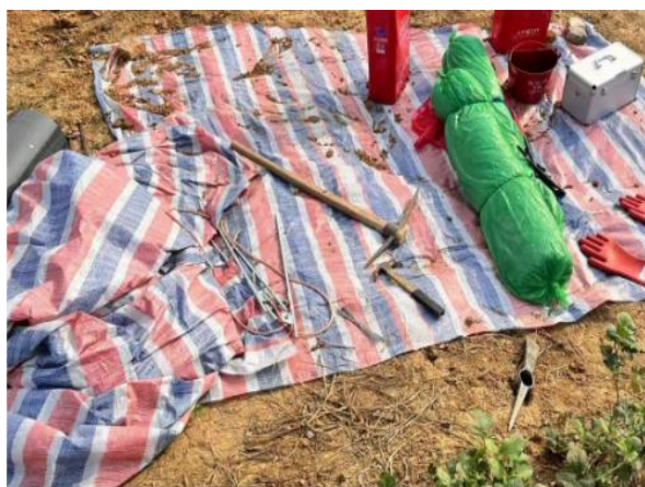
塔基施工区临时铺垫
