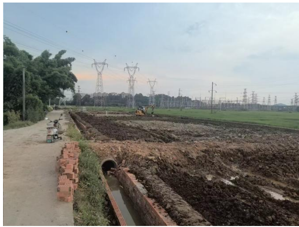
电缆施工区场地整治
