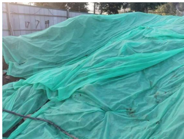
电缆施工区临时遮盖
