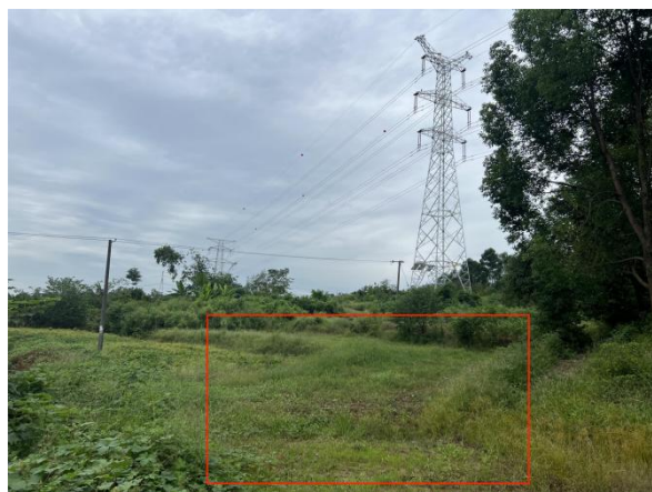
220kV 旗渡一二线 N17 施工便道恢复情况
