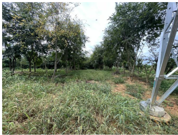
220kV 旗渡一二线 N2 施工便道恢复情况
