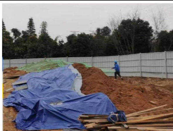
电缆施工区临时遮盖
