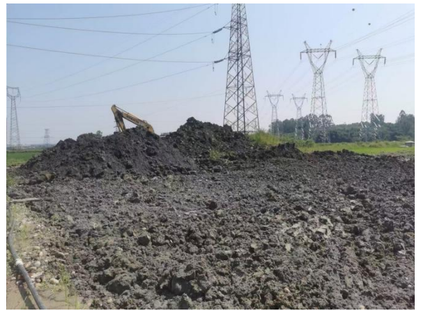
电缆施工区表土回覆
