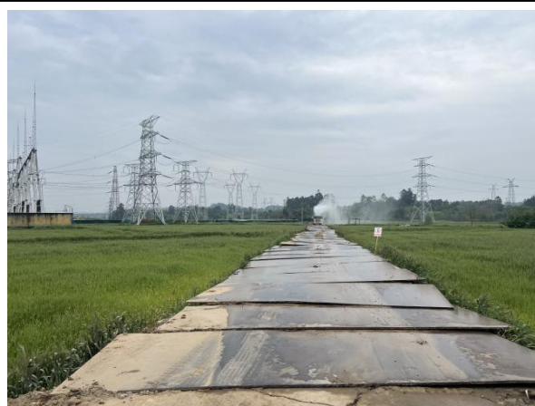
电缆施工区施工便道铺设钢板
