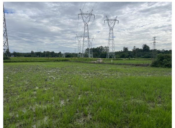
新建电缆沟（新津段）复耕情况
