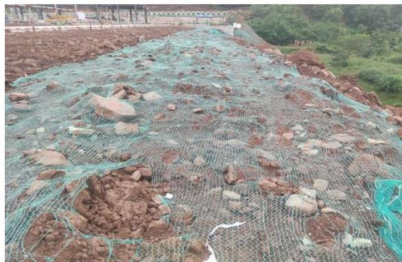
图 4.2-1 变电站进站道路边坡临时遮盖风化损毁较为严重
