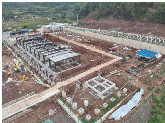
图 4.2-2 已完成护坡框格施工
