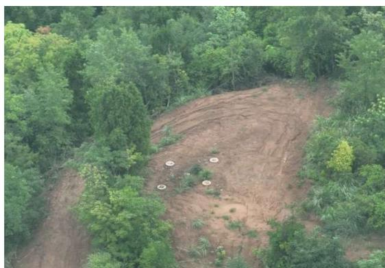
图 4.2-5 石门-太吉 N13 号施工道路冲刷严重
