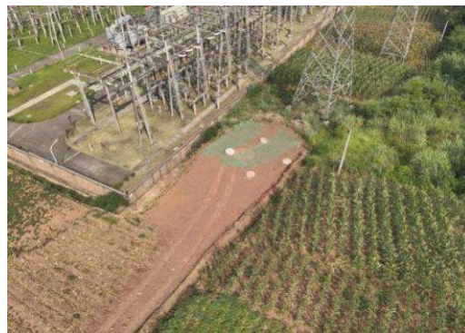
石门 N58 塔基施工场地平整
