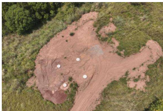
石门 N36 塔基施工场地平整
