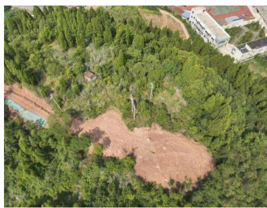
青龙坡 N35 塔基施工场地平整
