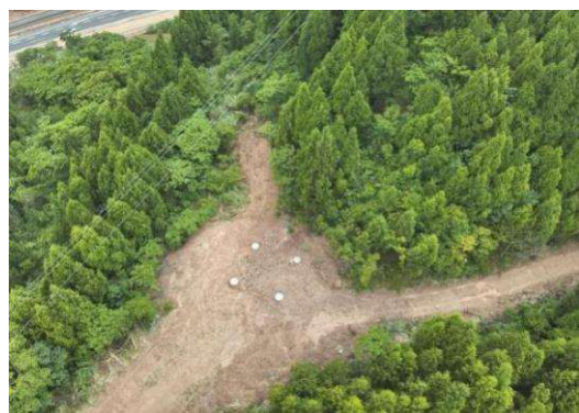
石门 N47 塔基施工场地平整
