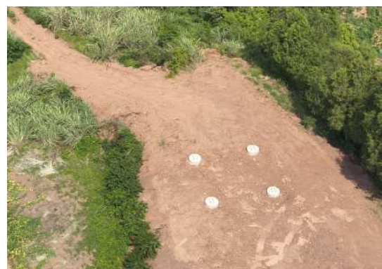
石门 N14 塔基施工场地平整
