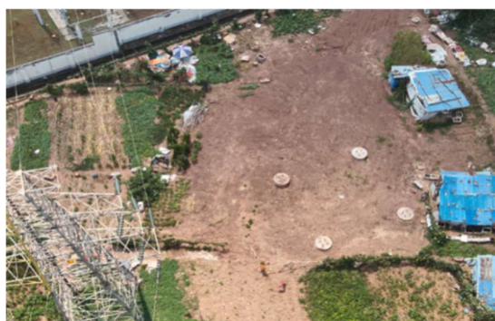
青龙坡 N40 塔基施工场地平整
