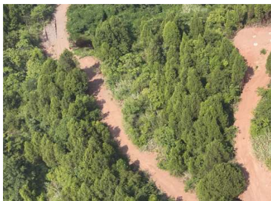
青龙坡 N1-9 施工道路
