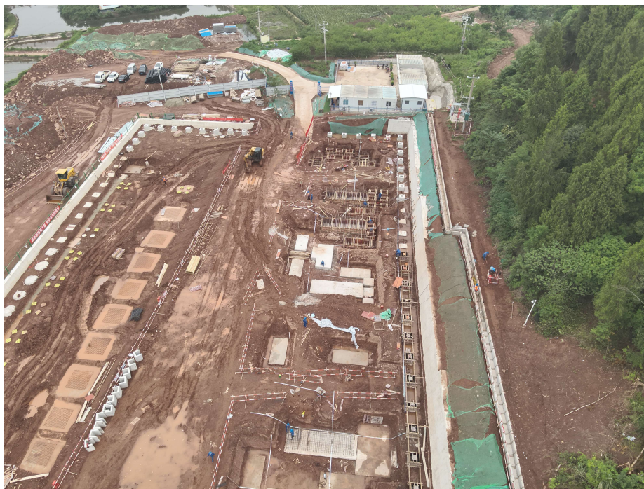
图 3.2-1 变电站边坡临时遮盖
