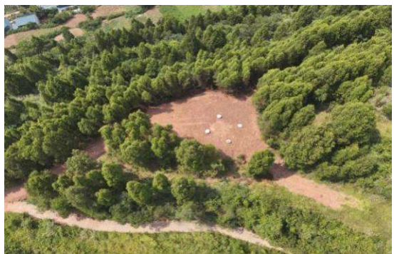
石门 N48 塔基施工场地平整
