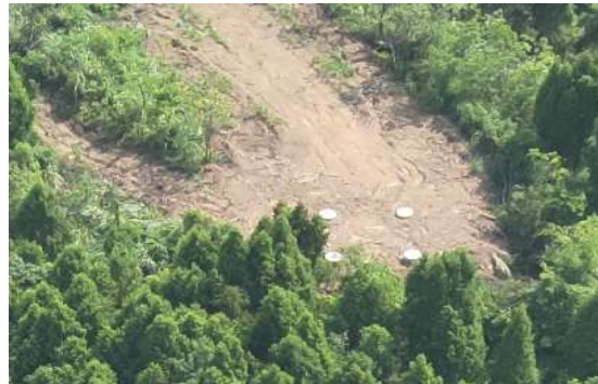
石门 N3 塔基施工场地平整
