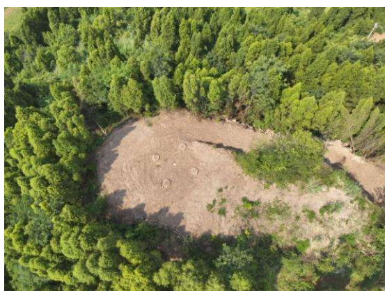
青龙坡 N34 塔基施工场地平整
