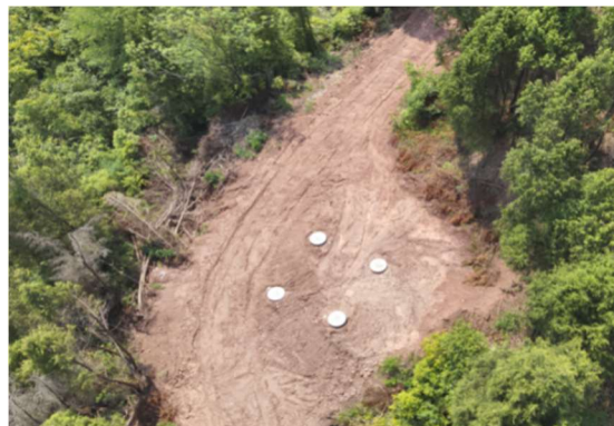
石门 N21 塔基施工场地平整
