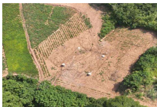
青龙坡 N14 塔基施工场地平整
