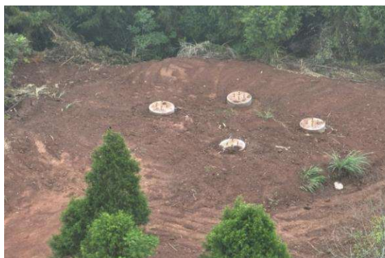
青龙坡 N2 塔基施工场地平整
