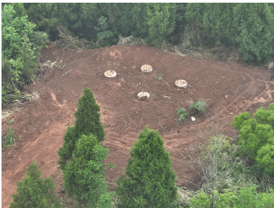
图 3.2-2 基础浇筑完毕塔位土地整治
