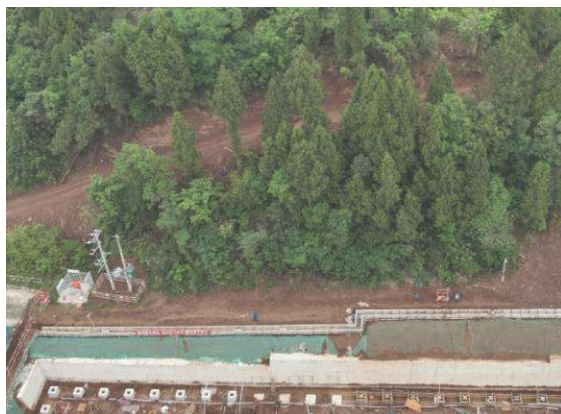
变电站东北侧截水沟及边坡临时遮盖
