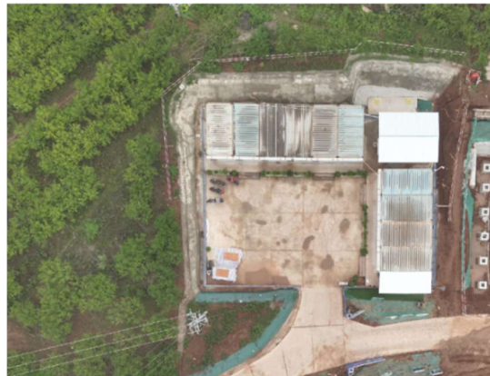
施工场地临时排水沟
