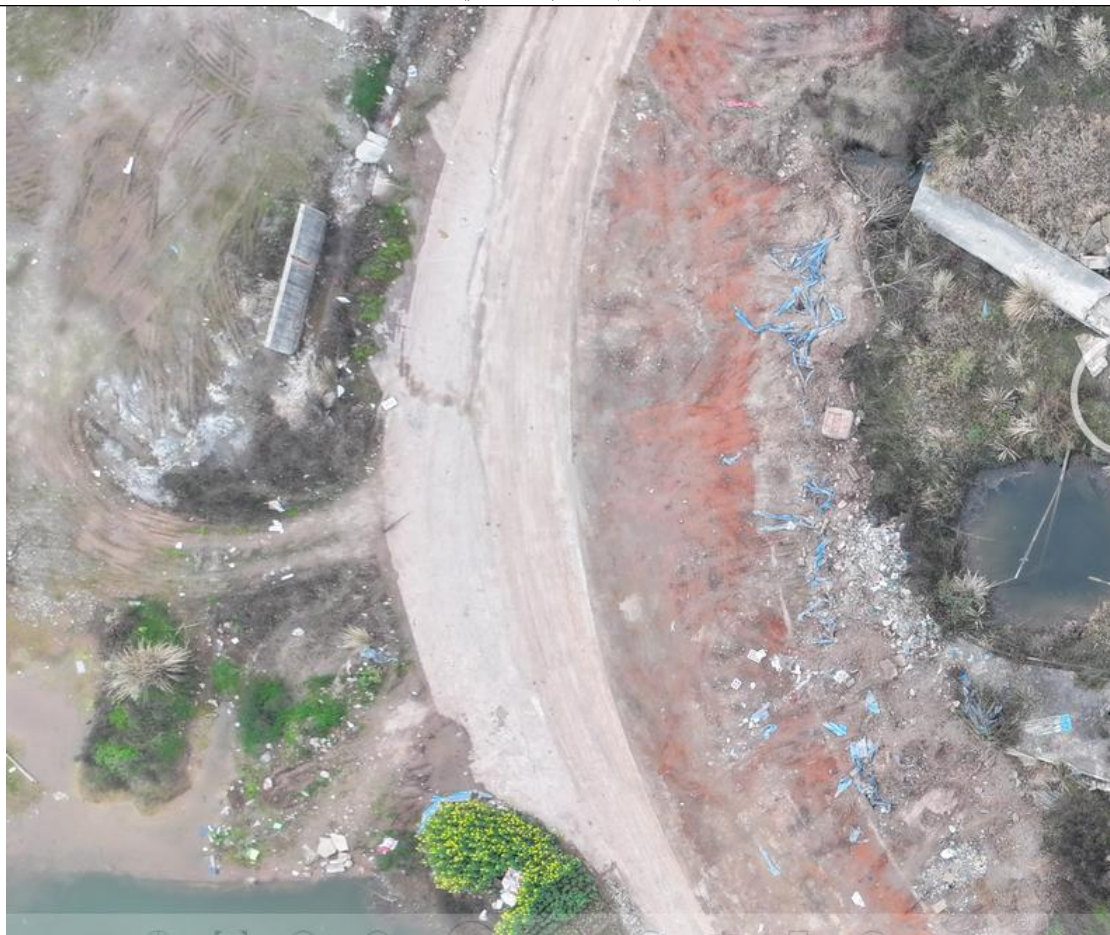
建兴变电站环境
