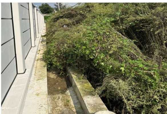
变电站截水沟
