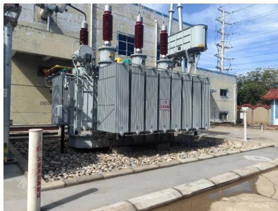
更换后的 1#主变压器
