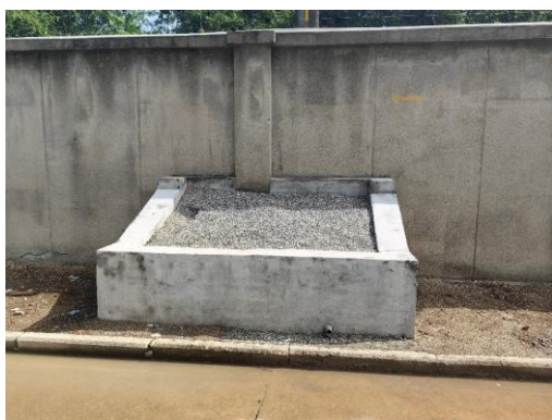
图 8-7 雒城 110kV 变电站内消防沙池
