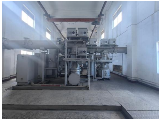
既有室内 110kV 配电装置
