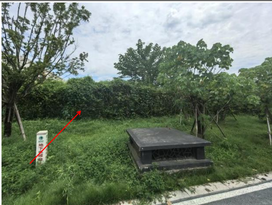
光明站外新建电缆通道现状
