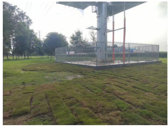
郭家堰-光明 M01 电缆终端塔现状
