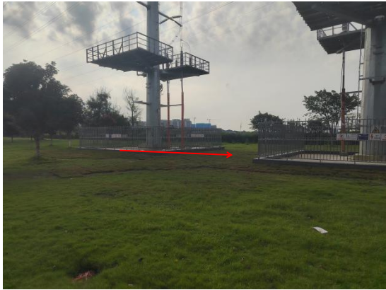
鱼鳊-光明 N01 电缆终端塔现状
