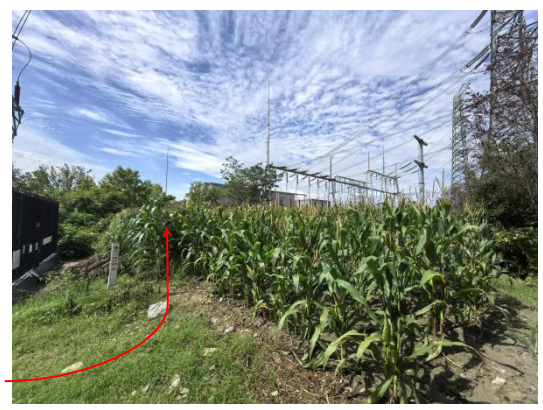
郭家堰站外新建电缆通道现状
