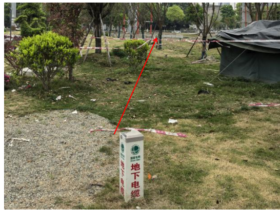
电缆终端塔处新建电缆通道现状
