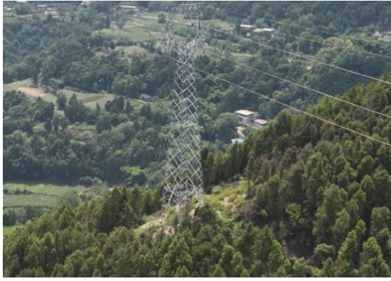
N28#新建铁塔
