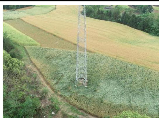
N6#新建铁塔
