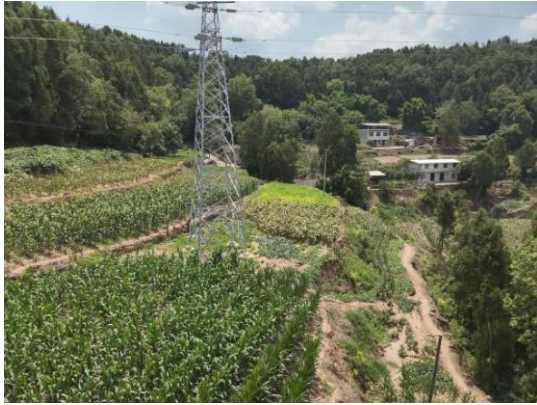
N33#新建铁塔
