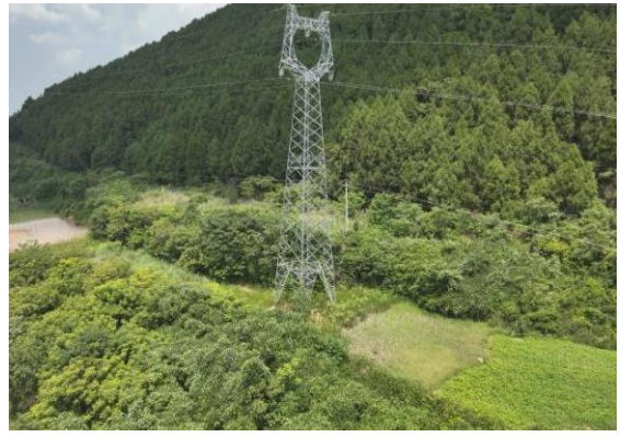
N30#新建铁塔
