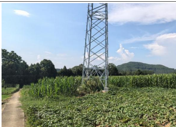
N3#新建铁塔
