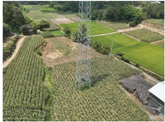
N32#新建铁塔
