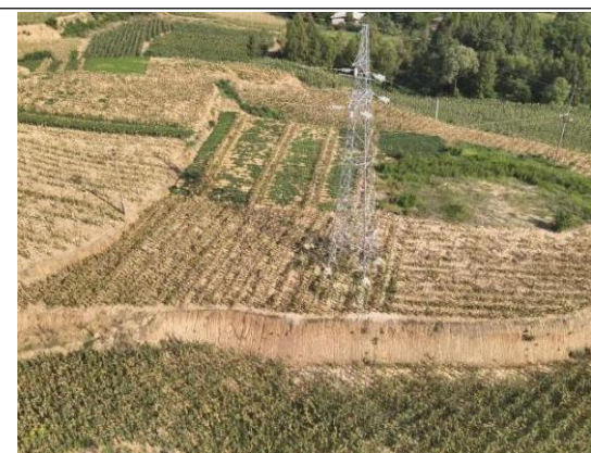
N10#新建铁塔
