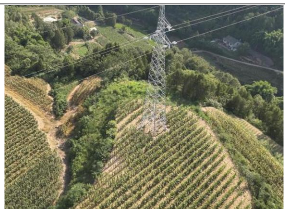
N9#新建铁塔
