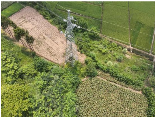
N35#新建铁塔
