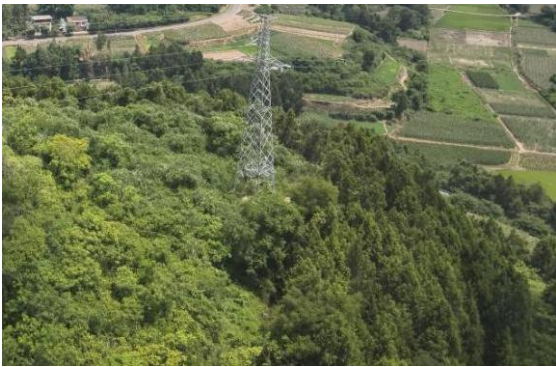
N31#新建铁塔
