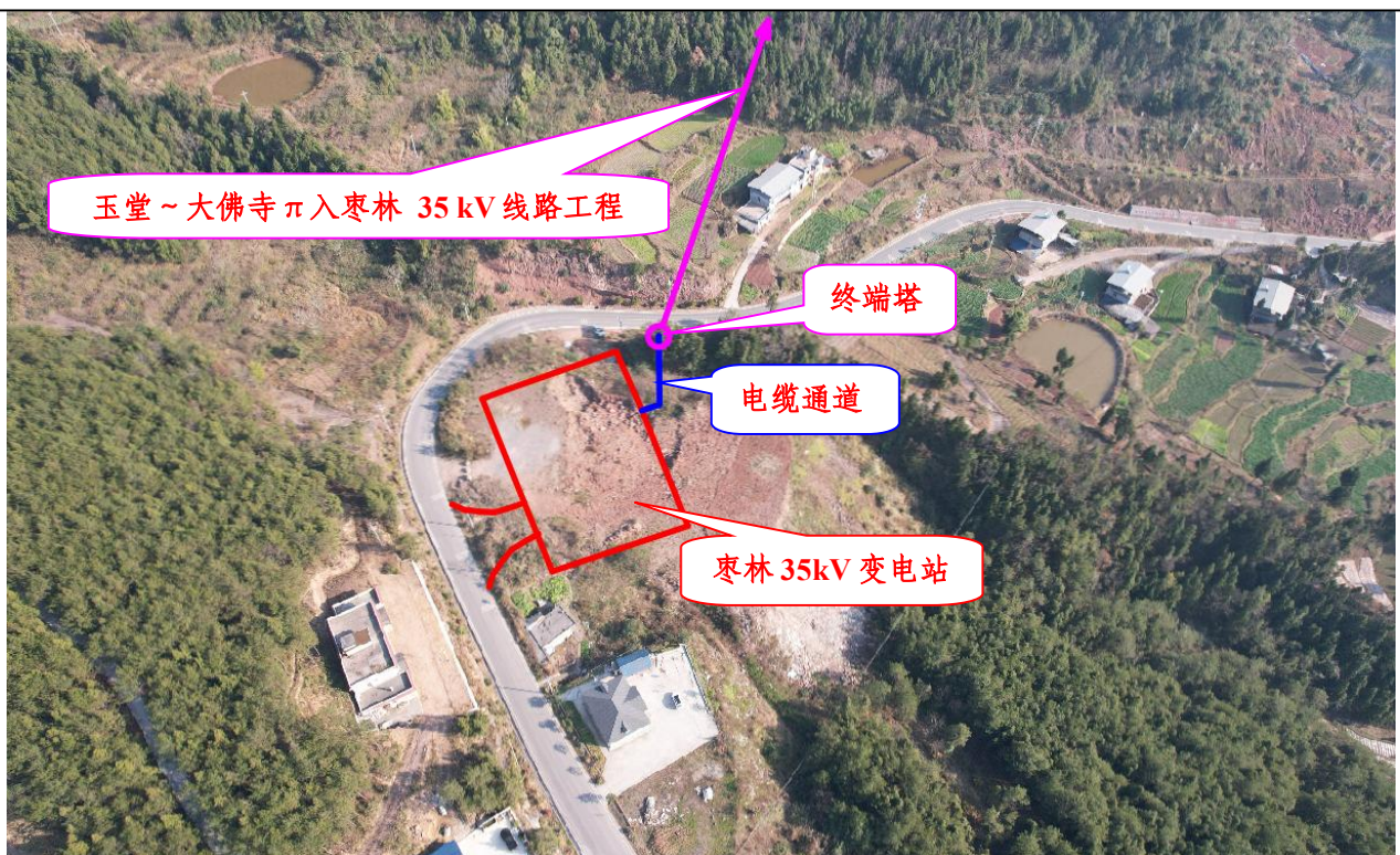
玉堂~大佛寺π入枣林 35 kV 线路枣林变出线段现状
