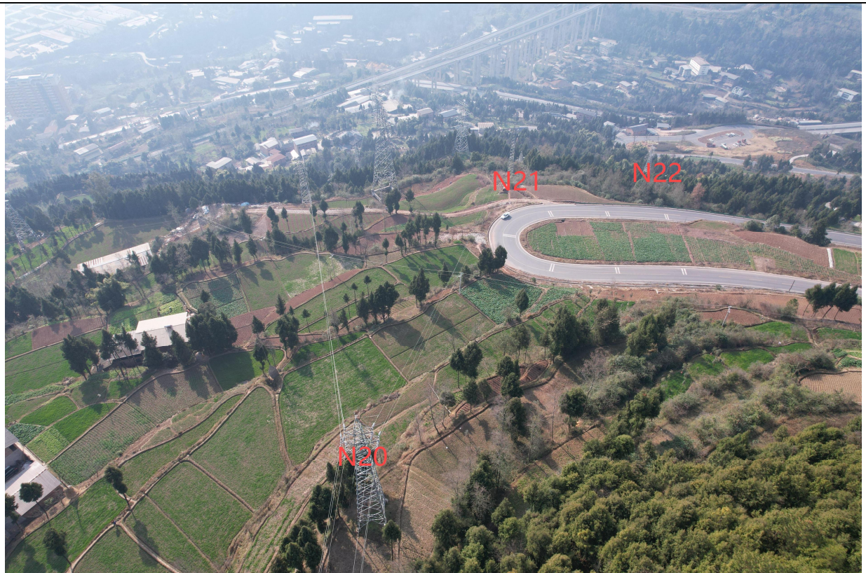
玉堂～正直 35kV 线路拆除铁塔现状
