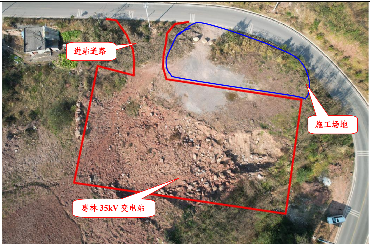
枣林 35kV 变电站现状
