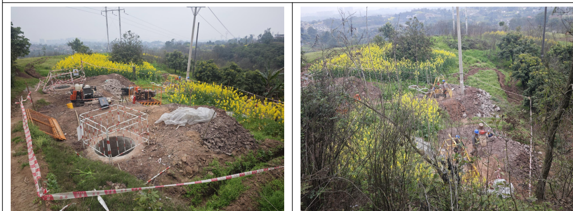
正在修建基础的塔基区域（缺乏临时苫盖）
