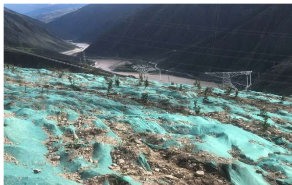
NA4-NB4-NB5 施工道路恢复情况
