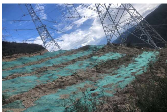
NA4 号塔施工场地恢复情况
