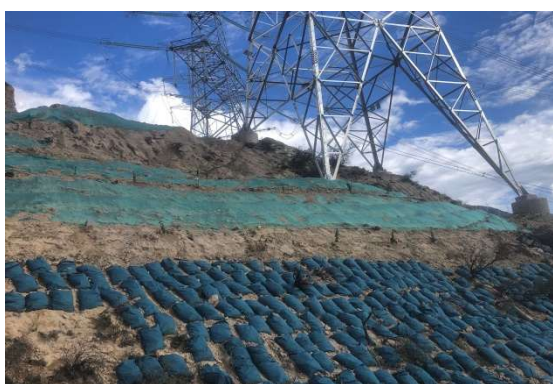
N3 号塔施工场地恢复情况
