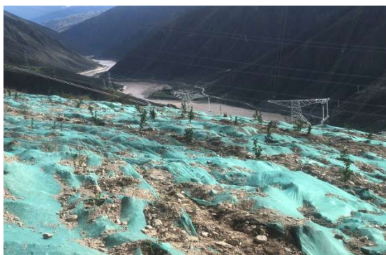
NB4 号塔施工场地恢复情况
