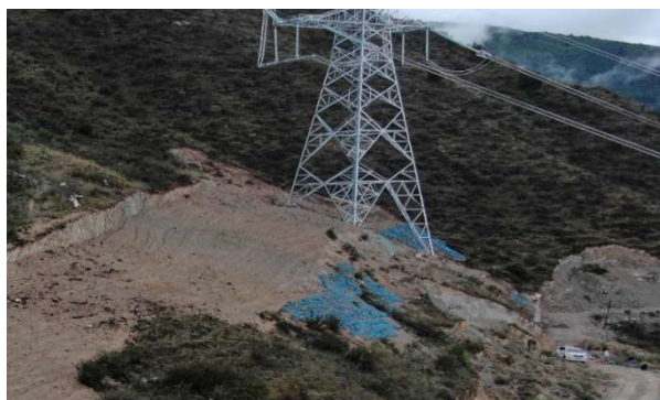
NB5 号塔施工场地恢复情况
