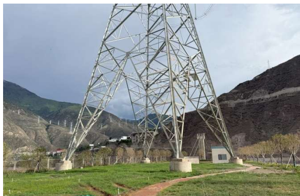
N1 号塔施工场地恢复情况
