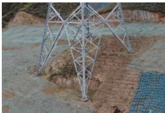
N2 号塔施工场地恢复情况
