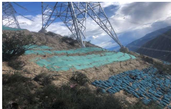
NA5 号塔施工场地恢复情况
