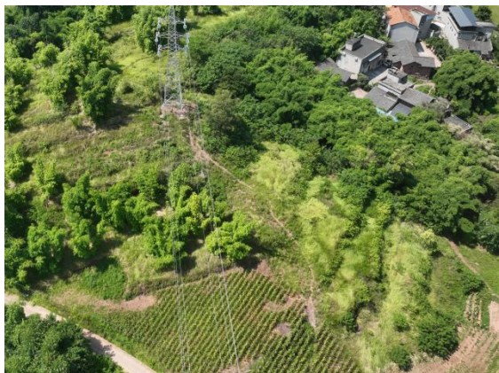
NA26 及施工道路
