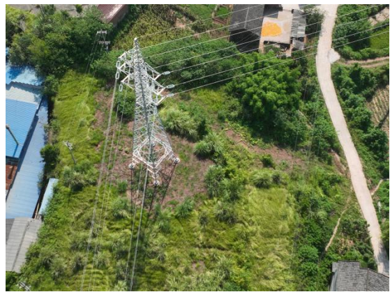
NA3 及施工道路
