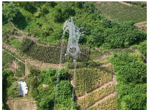
NA5 及施工道路
