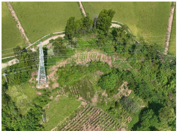
NA18 及施工道路
