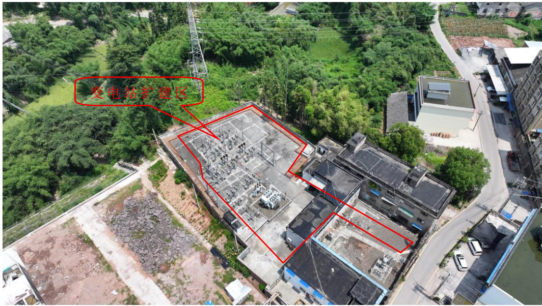
变电站扩建工程区现状
